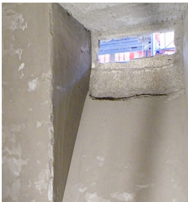
Étanchéité intérieure du mur extérieur avec enduit d'étanchéité
