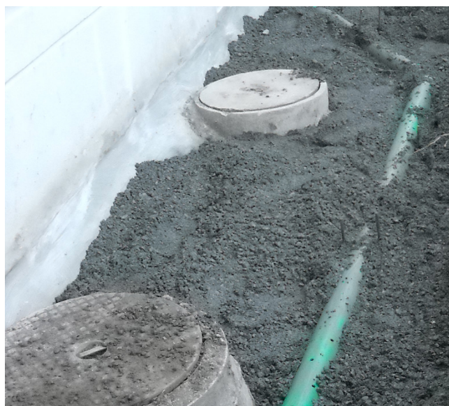
Etanchéité extérieure avec drainage
