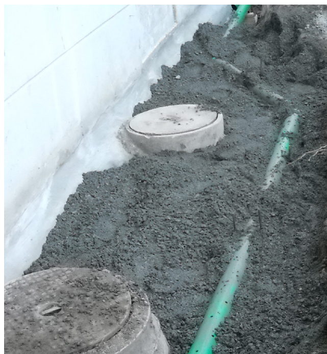
Étanchéité extérieure avec drainage
