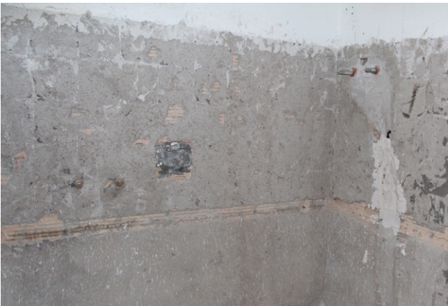
Les anciens carreaux ont été enlevés et Fixit 632 Rapid un enduit d'égalsation et de rénovation a été appliqué.
