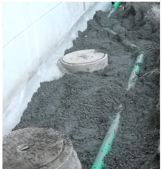
Aussenabdichtung durch eine Sickerleitung
