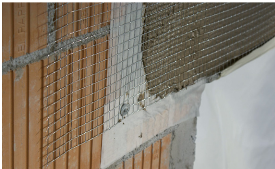
Armanet® montieren
