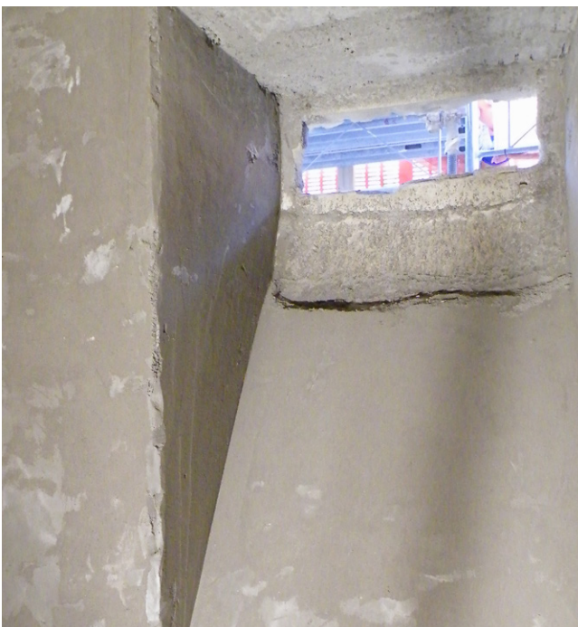
Innenabdichtung der Aussenwand mit Sperrputz
