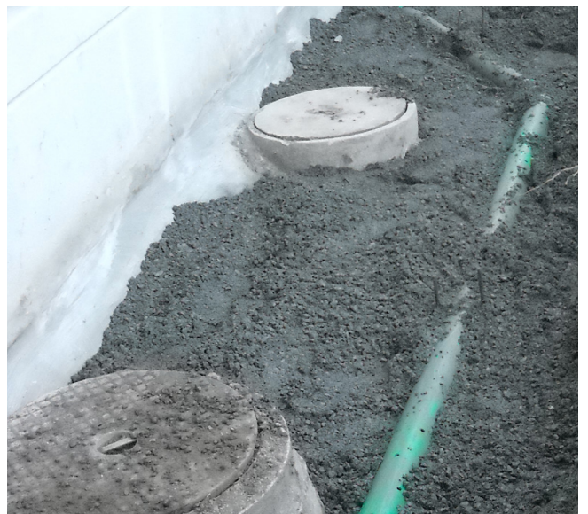
Aussenabdichtung durch eine Sickerleitung
