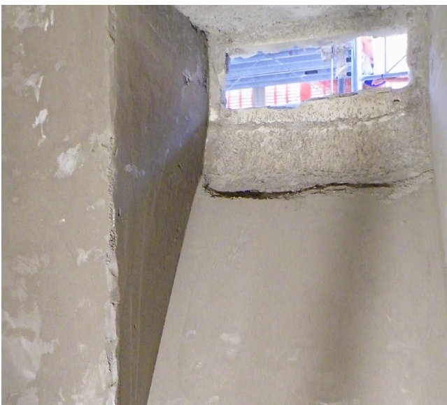
Innenabdichtung der Aussenwand mit Sperrputz
