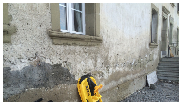
aufsteigende Feuchtigkeit
