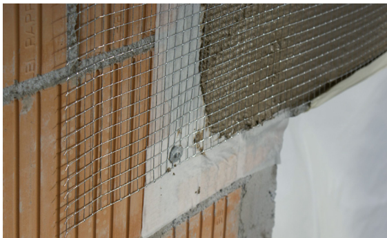
Armanet montieren
