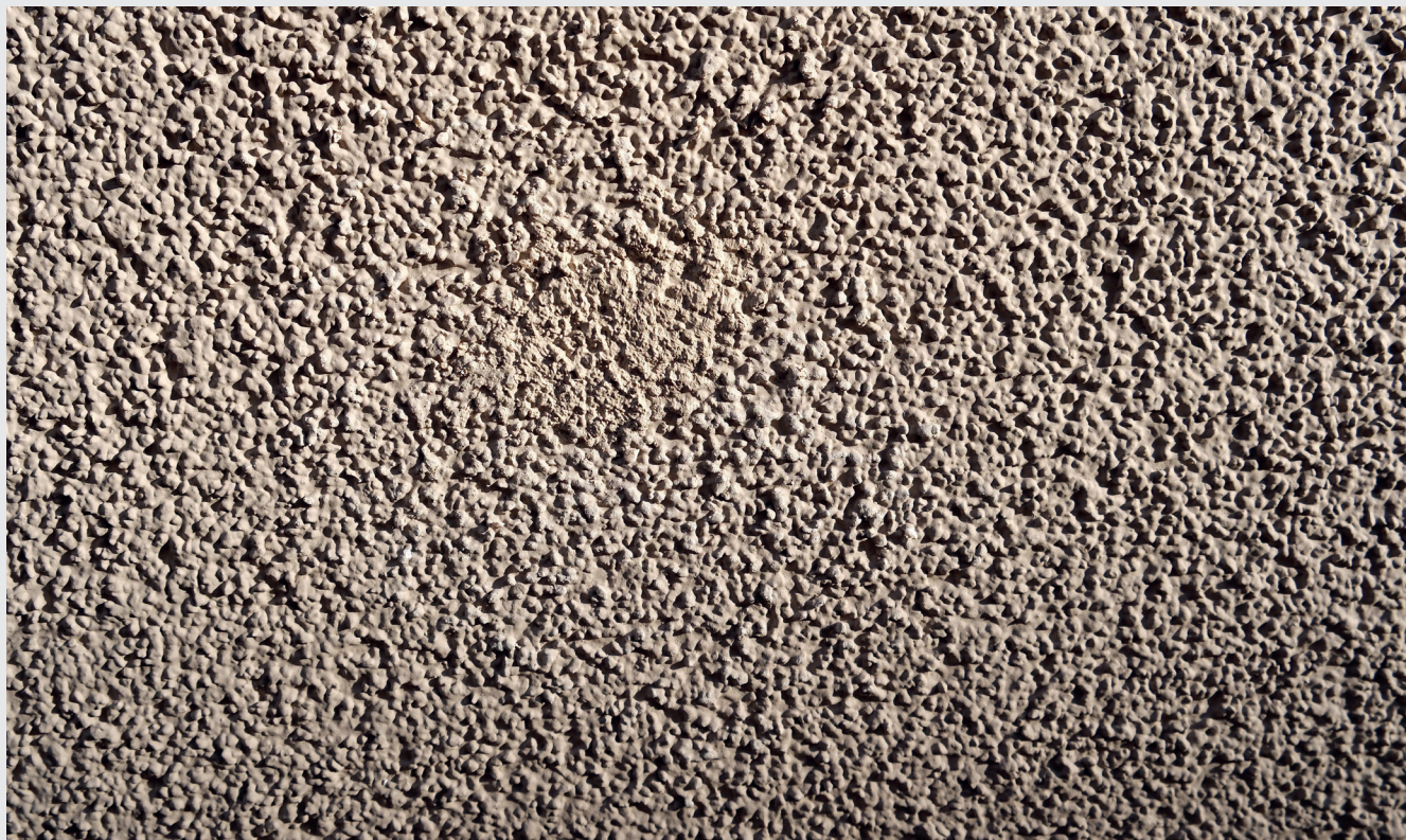
Résultat : trou d'ancrage de l'échafaudage obturé avec un matériau isolant
