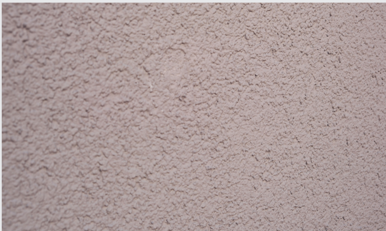
Résultat : trou d'ancrage de l'échafaudage obturé à l'aide d'un bouchon d'ancrage
