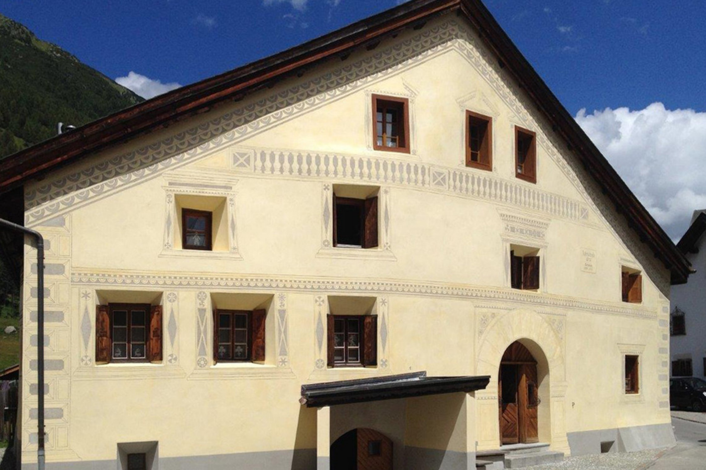
Edificio storico «Chesa Palmira» ristrutturazione Bever
