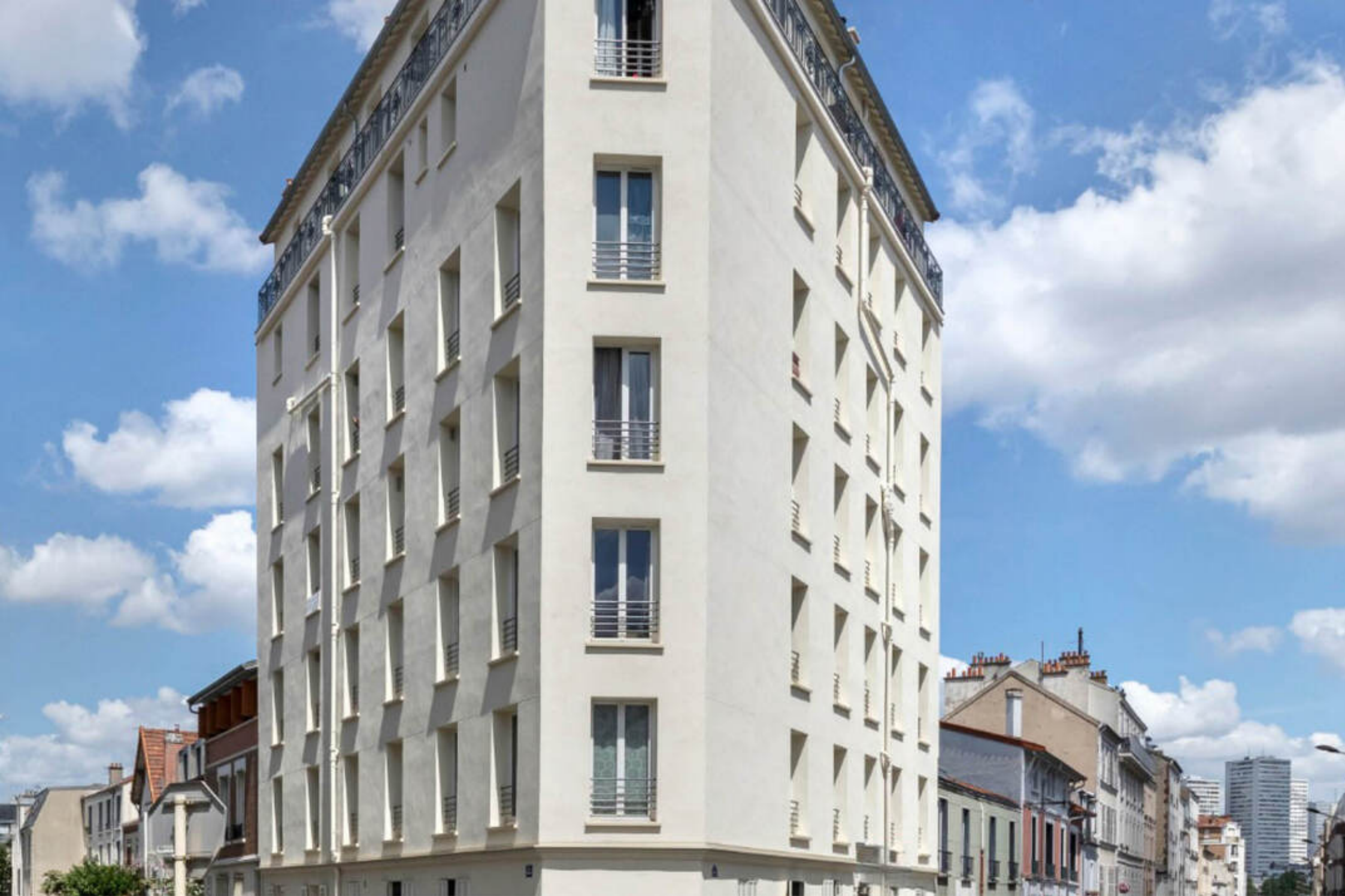
Immeuble collectif rénovation Kremlin-Bicêtre Paris (France)
