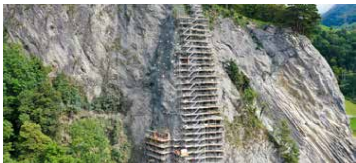
Stabilizace skal Axenstrasse, Sisikon UR
