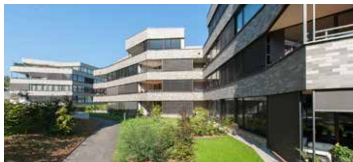
Výstavba v kantonu Binningen, Švýcarsko
