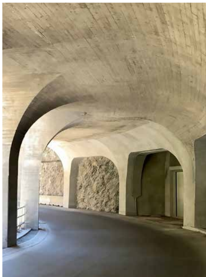
Rekonstrukce tunelu Viamala 1, Švýcarsko
