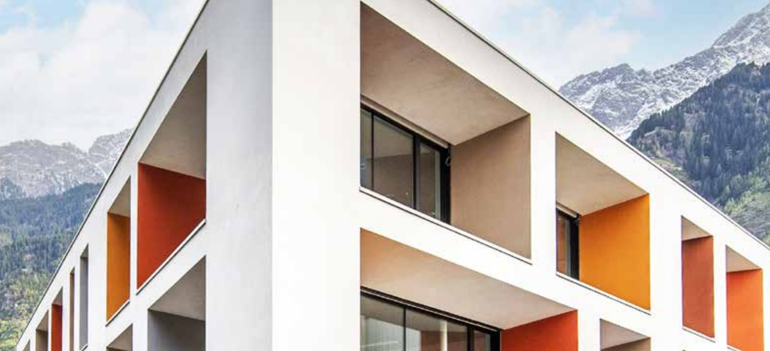
Administrativní budova v Partschinsu, Itálie
