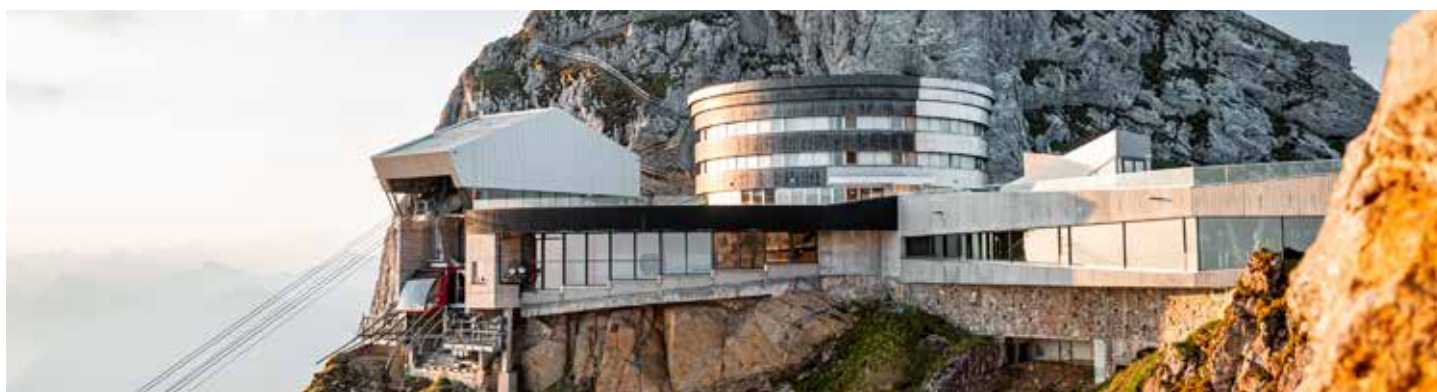
Rozšíření čekárny, horská stanice Pilatus Kulm, Švýcarsko
