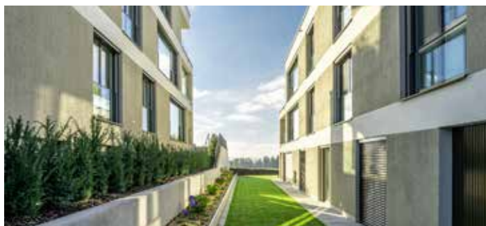
Bytová výstavba v kantonu Curych, Švýcarsko
