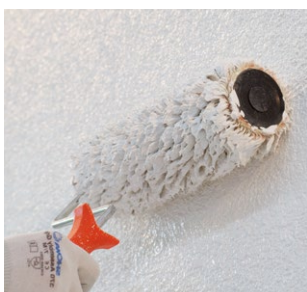
7 Überarbeitung mit hoch diffusionsöffener Silikatfarbe
