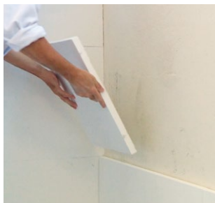
4 Positionierung der Dämmplatten
