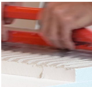
3 Verklebung der Dämmplatten
