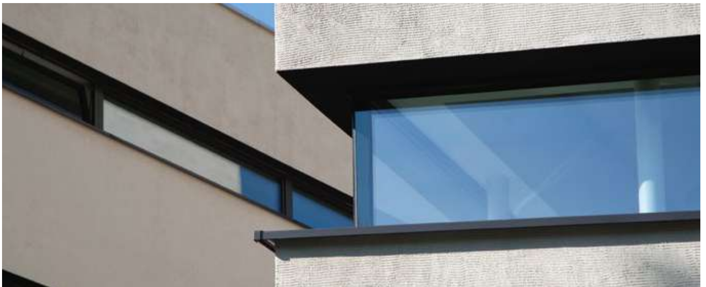
Referenzobjekt Arbeiterkammer Bludenz – RÖFIX Wärmedämmsystem und Putz-Oberfläche in Besenstrich-Optik
