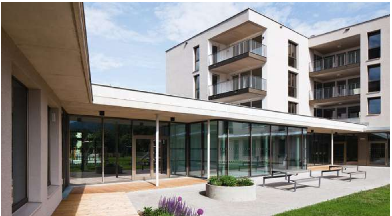
Referenzprojekt Haus im Leben, Innsbruck – Einsatz von RÖFIX Wärmedämmverbundsystemen und Creteo®Gala Produkten.
