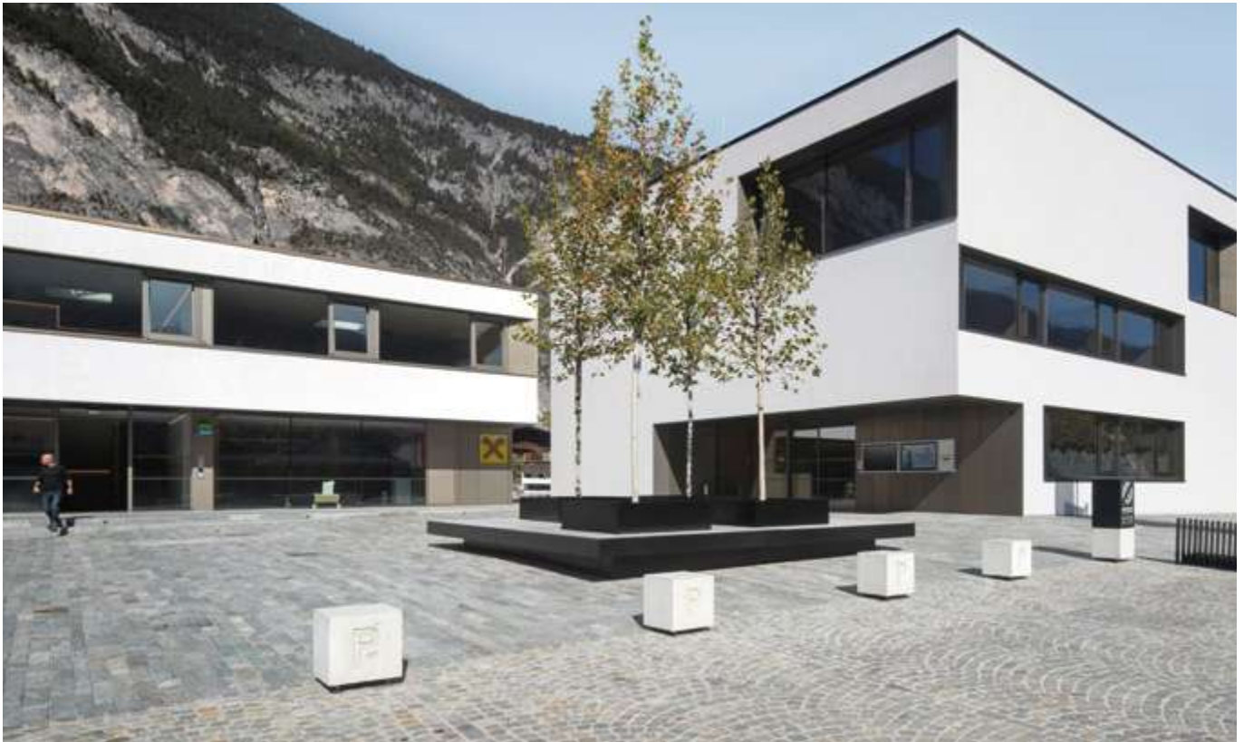
Referenzprojekt Gemeindezentrum Haiming, Tirol – Einsatz von Trass-Pflasterfugenmörtel
