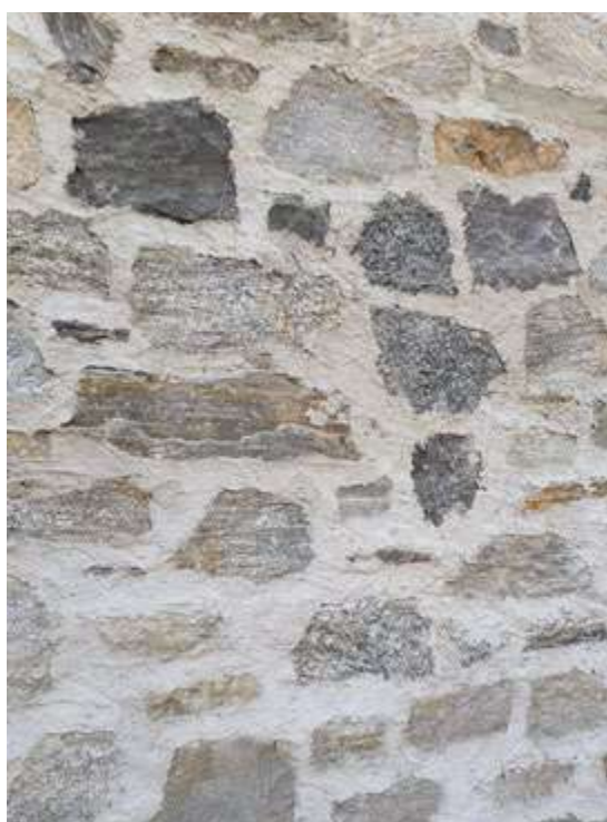
Referenzprojekt Alpinsportzentrale Schruns – Einsatz von Natursteinfugenmörtel
