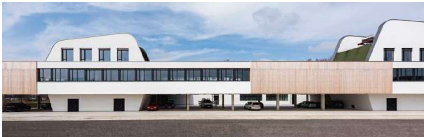
Referenzobjekt Lakeside-Park Klagenfurt – Einsatz von RÖFIX Wärmedämmsystemen
