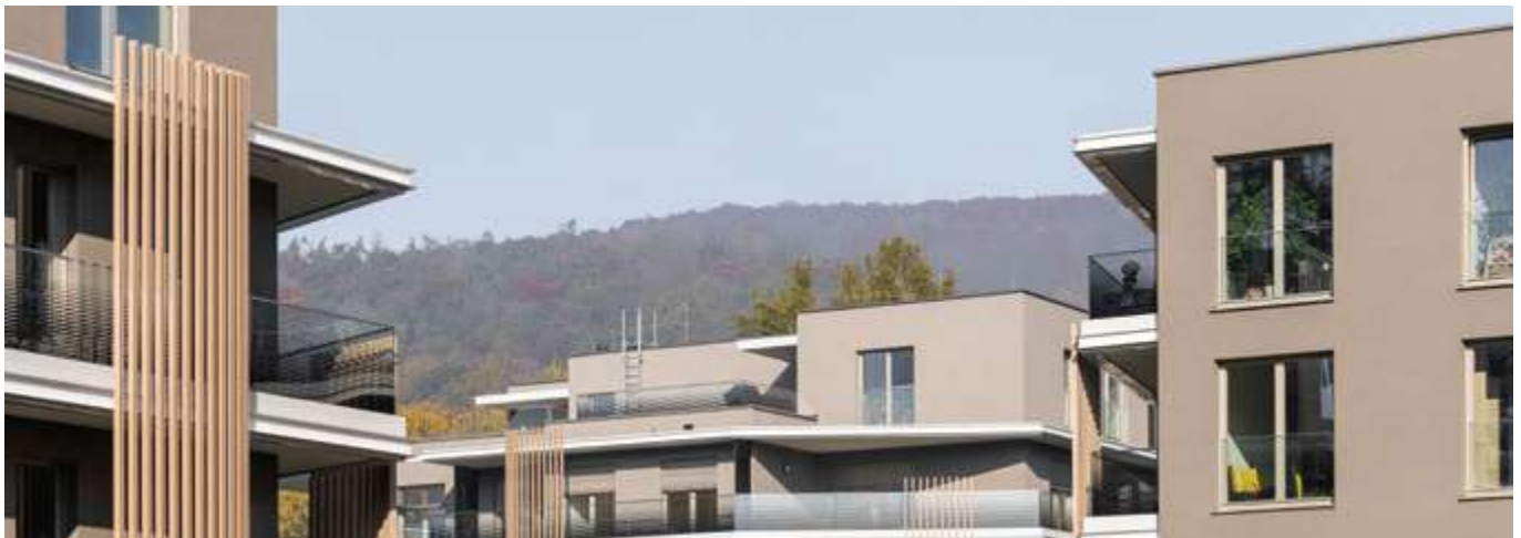
Referenzobjekt Das Levels, Linz – Einsatz von RÖFIX Wärmedämmssystemen mit SiSi-putz®
