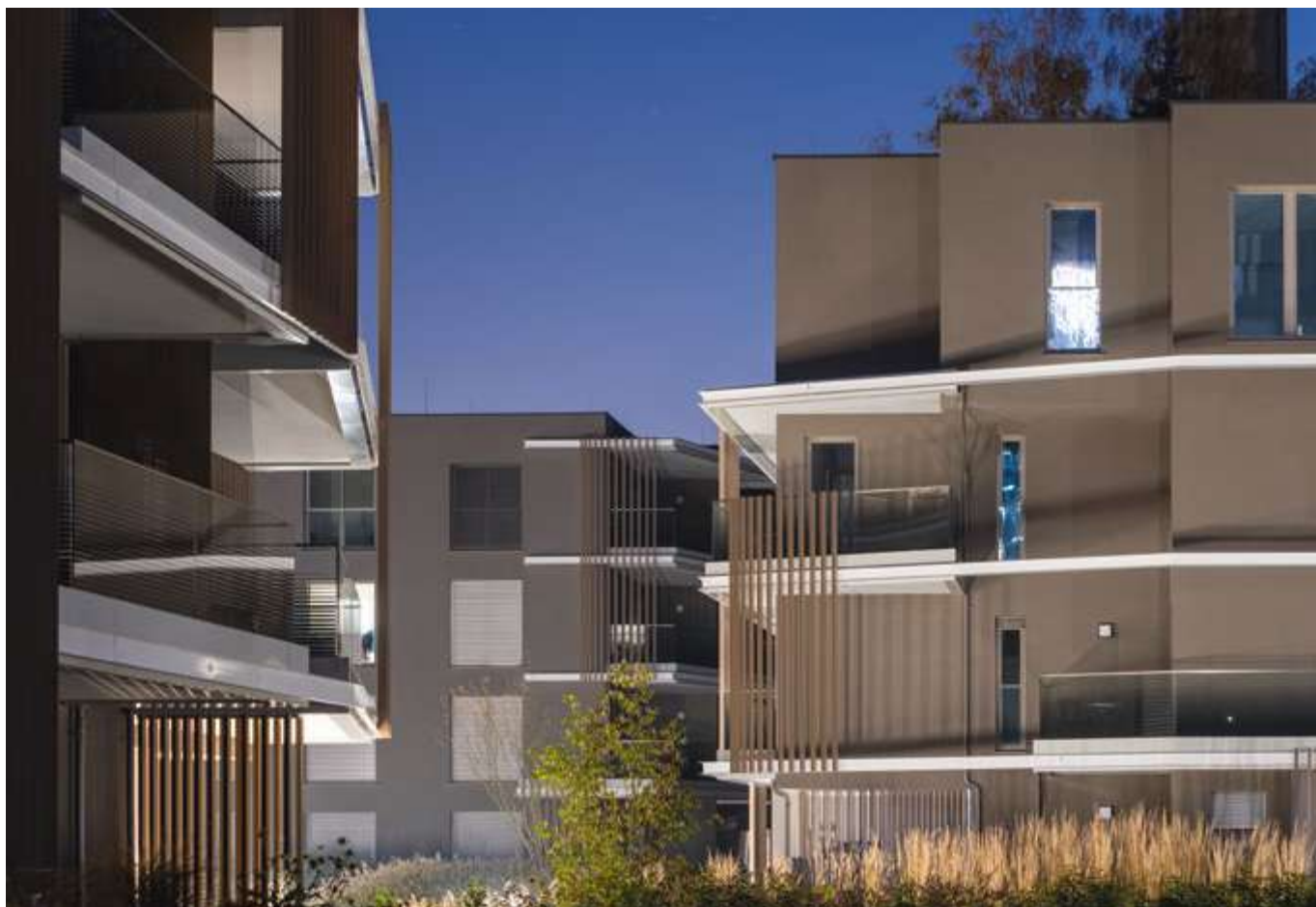
Referenzprojekt Das Levels, Linz – Einsatz von RÖFIX Wärmedämmsystemen mit SiSi-Putz®
