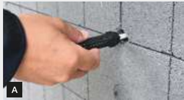
BOHRLOCH UND KLEBEKANAL
