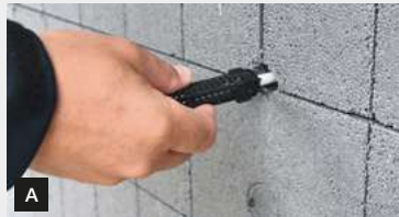
BOHRLOCH UND KLEBEKANAL
