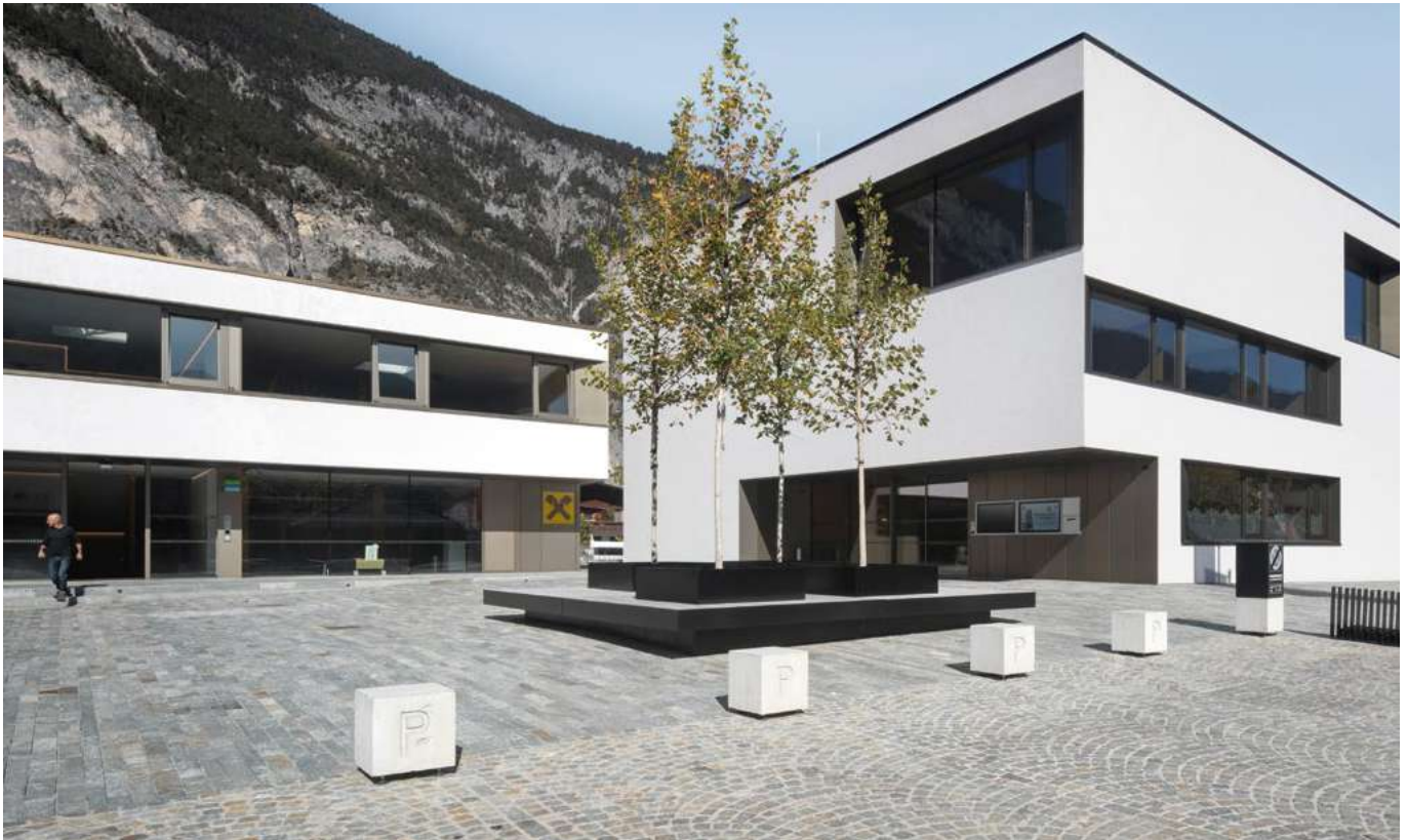
Referenzprojekt Gemeindezentrum Haiming, Tirol – Einsatz von Trass-Pflasterfugenmörtel
