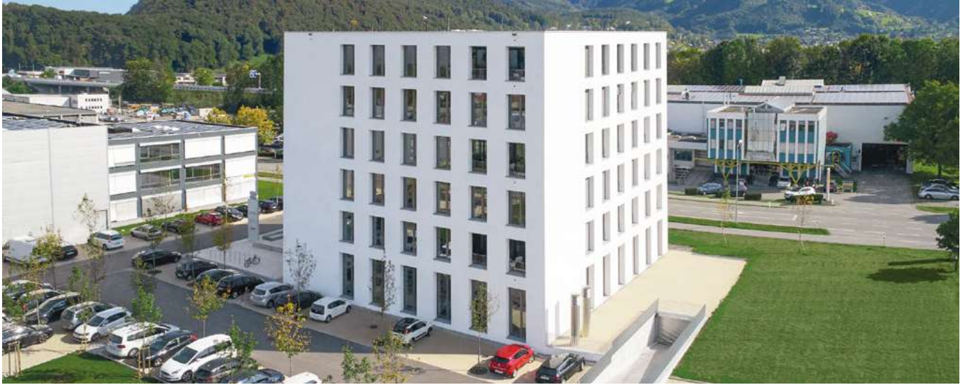
Referenzprojekt Interpark Focus 40, Röthis – Einsatz von RÖFIX Unterputzen
