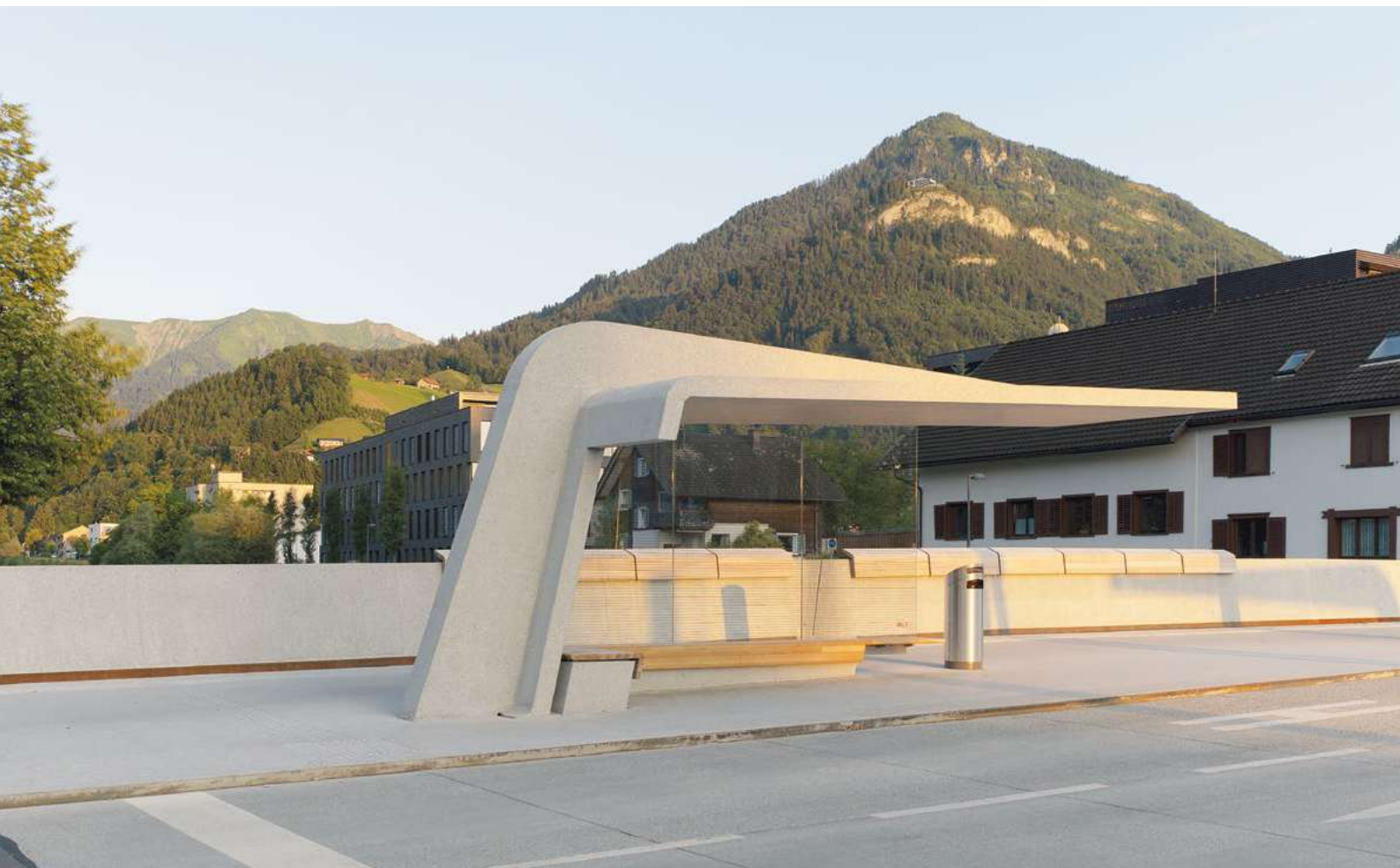
Referenzprojekt Sägerbrücke Dornbirn. Einsatz von Creteo® Shot zur Hangsicherung
