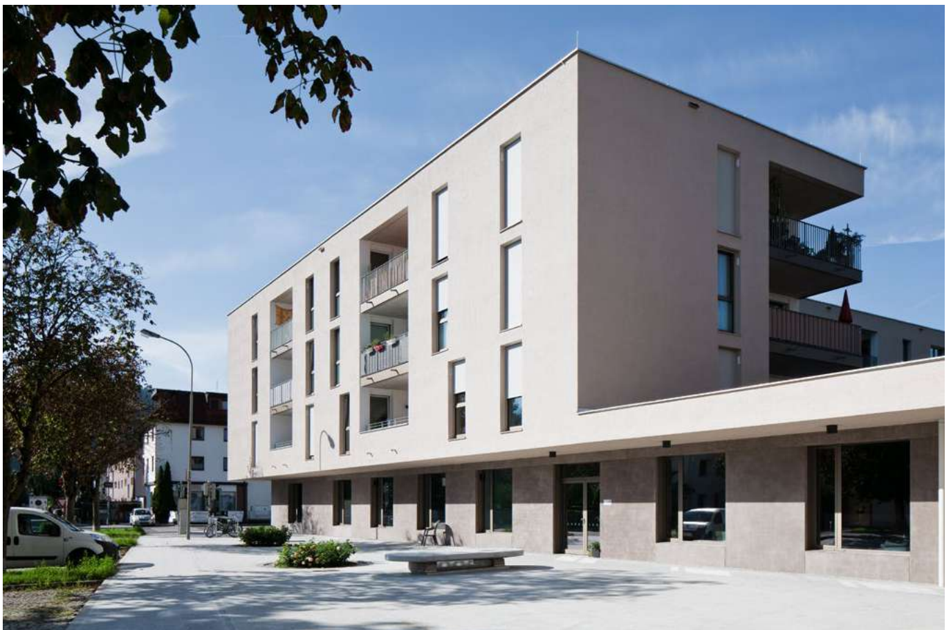
Referenzprojekt „Haus im Leben“ Innsbruck, Tirol - Vorplatzgestaltung mit Produkten der Linie Creteo® Gala
