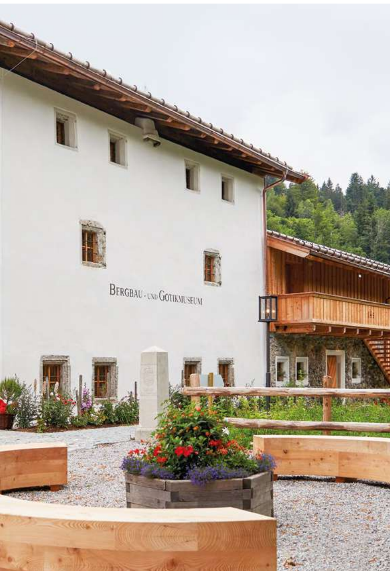
Referenzprojekt Bergbau- und Gotikmuseum Leogang, Einsatz von RÖFIX Produkten zur denkmalgerechten Sanierung.
