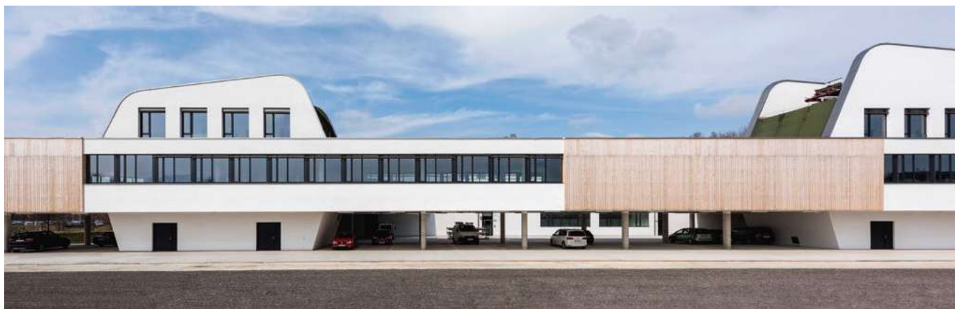
Referenzobjekt Lakeside-Park Klagenfurt – Einsatz von RÖFIX Wärmedämmsystemen
