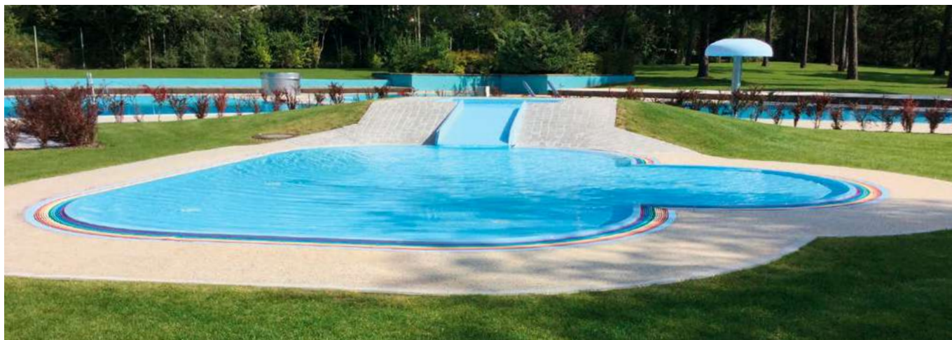
Referenzprojekt Schwimmbad Mieming, Tirol - Einbau von halbstarre Deckschicht Creteo® Phalt
