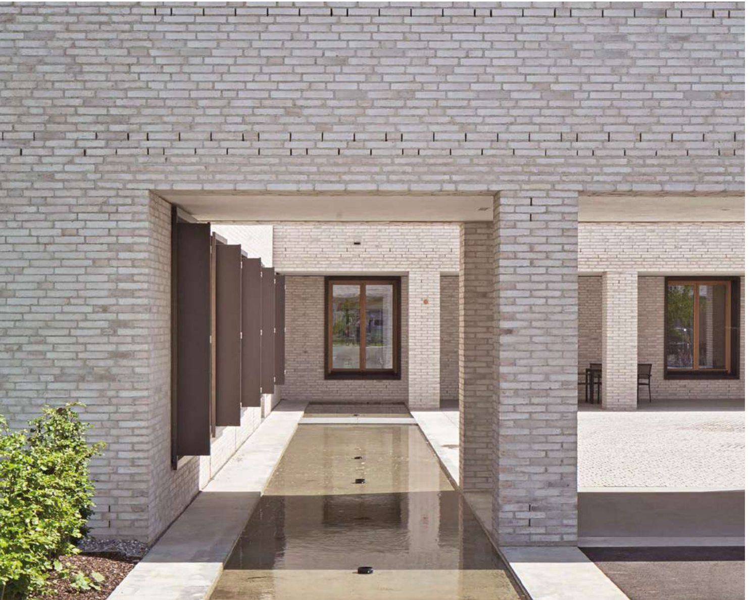
Referenzprojekt Pflegeheim Birkenwiese, Dornbirn – Einsatz von Zement Mauermörtel
