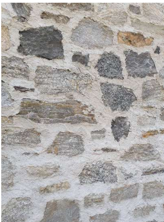
Referenzprojekt Alpinsportzentrale Schruns – Einsatz von Natursteinfugenmörtel
