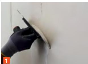
Ispuniti pojedinačne fuge ili fuge i cijele površine, ovisno o zahtjevima završne obrade.
