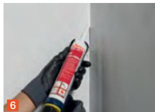
Prije bojanja, svi spojevi između površina gipsnih ploča i susjednih površina moraju se zalijepiti brtvilom i ljepilom.
