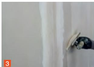
Ovisno o zahtjevima za konačni izgled površine, površine je potrebno pregletati i izbrusiti više puta. Na spojevima s drugim građevinskim materijalima potrebno je izvesti „dilataciju“.
