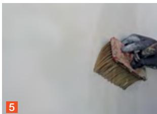
Površine od gipsnih ploča uvijek moraju biti prethodno tretirane odgovarajućim predpremazom prije daljnje obrade. Svaki predpremaz mora biti uskladen sa sustavom sljedećeg premaza. Predpremaze je potrebno koristiti nepigmentirane i nanositi četkom.
