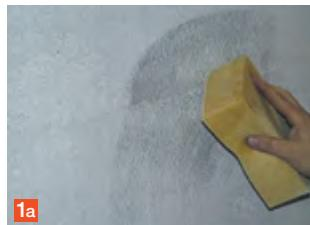
Masne površine moraju se odmastiti prije nanošenja premaza, npr. nitro razrjeđivačem ili sličnim sredstvom.
