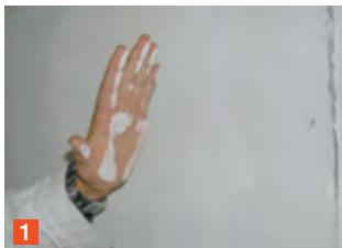
Površine koje se premazuju moraju biti suhe, stabilne, ravnomjerno upijajuće, bez kontaminacija ( npr. prljavštine, cvjetanja vapna, pljesni ), imati ujednačenu strukturu i biti ravne.
