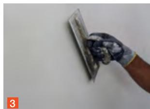
Na žbukama i betonskim podlogama, nedostatke kao što su pukotine ili šupljine potrebno je ispuniti odgovarajućom glet masom. Broj slojeva ovisi o stanju podlage, kao i o kvalitativnim Q zahtjevima.
