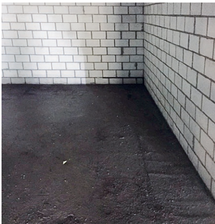
Kalksandsteinwände stark saugend, mit PE-Folie abkleben
