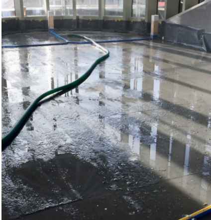
Beton mehrmals gut vornässen
