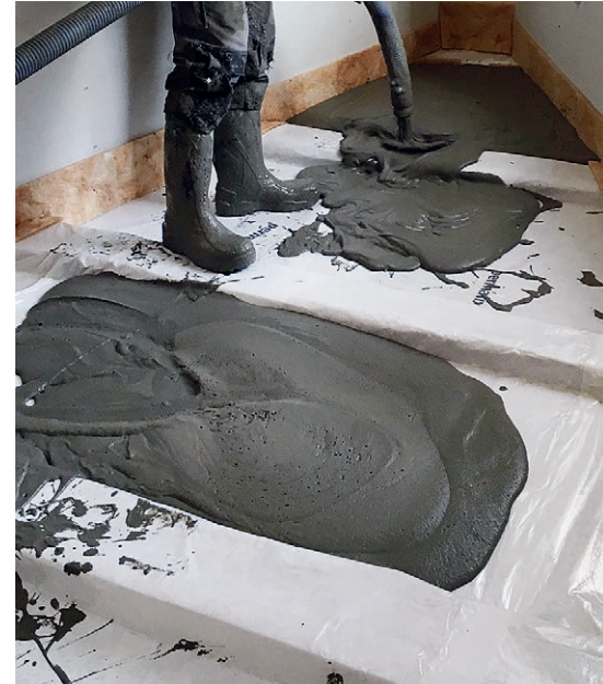
RÖFIX POR Einbau auf Holzbalkendecke
