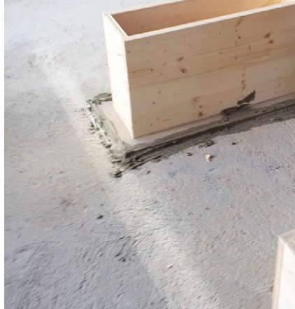
Abdichtung der Schalungen mit Schnellmörtel oder Bauschaum
