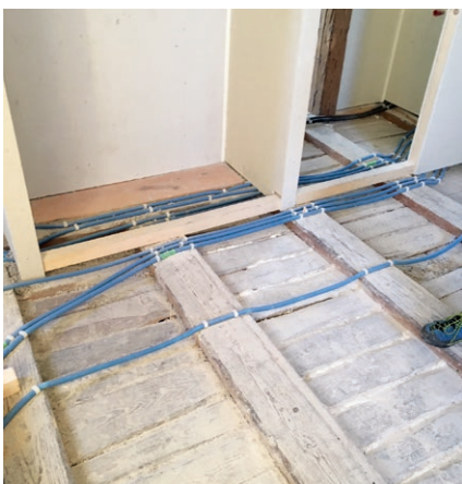
Holzbalkendecke mit PE-Folie (doppelt verlegt)
