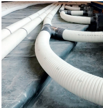
Flächen vorgängig mit PE-Folie abkleben
