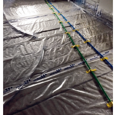
Abdecken mit PE-Folie (doppelt) bei bewohnten Objekten
