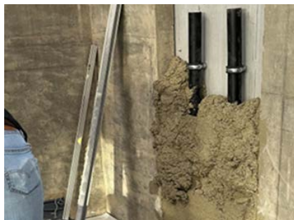
Boucher les fentes dans les murs
