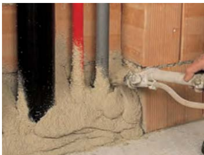
Obturer les fentes dans les murs à l'aide de machines
