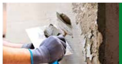
Sanace / renovace renovace ve stylu
