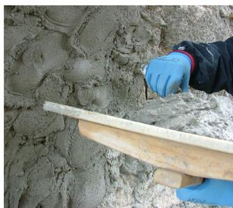
Bouchon avec enduit barrière Fixit 217
