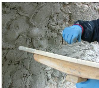
Egaliser avec Fixit 217 Enduit d'étanchéité.
