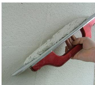
Enduit de rénovation Fixit 462 d'environ 10 mm d'épaisseur comme couche d'enduit anti-humidité
