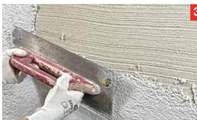
3. Sur la couche d'armature, appliquer le crépi lavé Greutol Enduit de blanchiment 794 avec un tout petit peu plus que l'épaisseur de grain.
