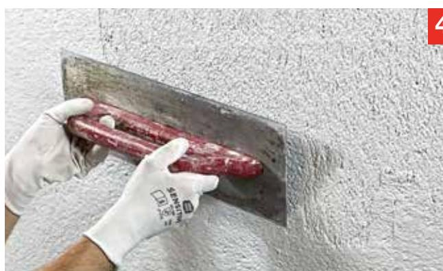
4. La surface enduite doit être absolument plane après l'application de l'enduit. En fonction de la texture et de l'aspect souhaités, l'épaisseur de la couche peut être augmentée jusqu'à un maximum de 1,5 fois le grain.
