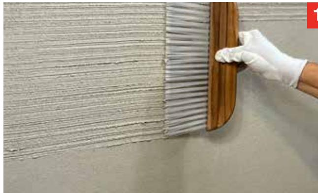
1. Gratter la couche d'armature horizontalement avec une brosse à gratter en guise de préparation pour la couche d'enduit suivante.
