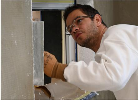
Im Folgekurs des Grundkurses B61 werden im Aufbaukurs B62 insbesondere die Details von Kompaktfassaden behandelt. Besonderes Augenmerk wird auf das richtige Versetzen von diversen Fensterbanktypen und das Einbauen von Komplementärteilen gesetzt.
