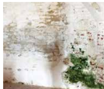
Originalzustand vor der Sanierung.
