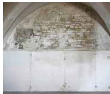
Wärmedämmputz 5 Jahre später
