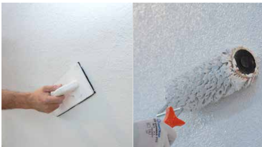
Structurare cu masă de șpaclu adezivă specială RÖFIX Renopor® | Acoperire cu vopsele cu difuzie deschisă la vaporii
