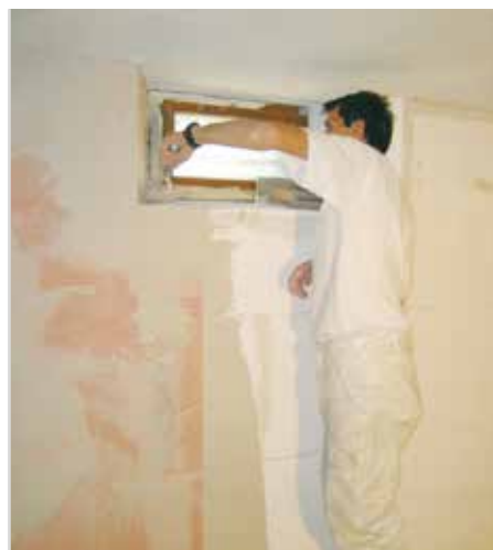
Montaj cu pană de ajustare RÖFIX Renopor® Anpasskeil
