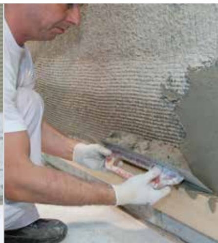
Tencuială de soclu RÖFIX pe cărămidă
