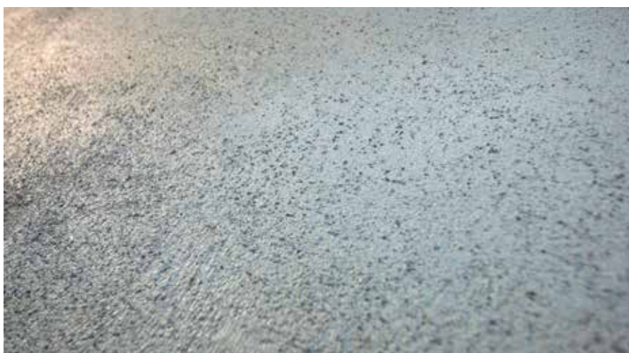
RÖFIX 397, structurarea celui de-al doilea strat
