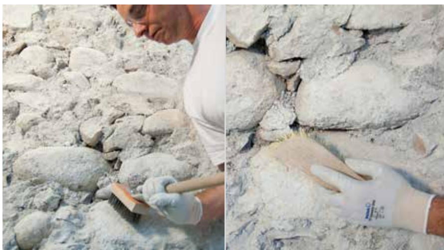
Decopertarea și curățarea zidăriei
