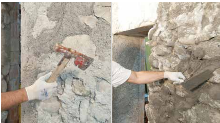
Îndepărtarea prin lovire a tencuielii vechi | Astuparea cu/proiecția de tencuială de bază poroasă RÖFIX 648/HASIT 208
