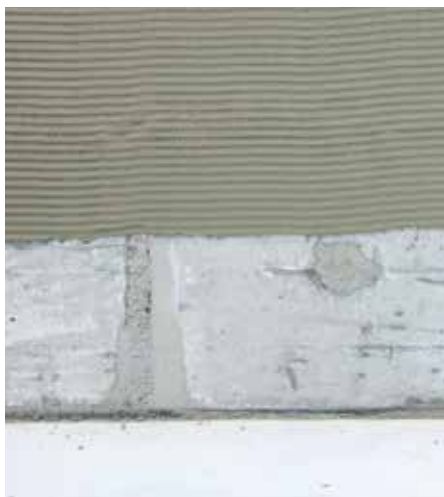
Strat aderent RÖFIX pe beton
