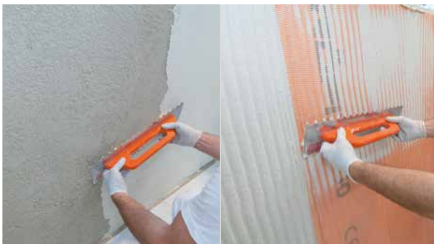
Armarea stratului de tencuială izolatoare
