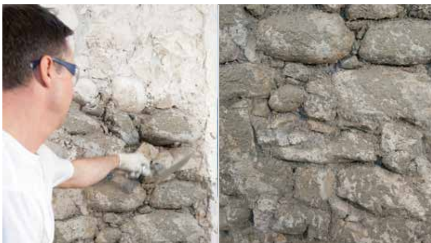
Acoperire prin proiecție cu mortar de șprîț RÖFIX 671 Sanier-Vorspritzmörtel cu acoperire a 60% din suprafață
