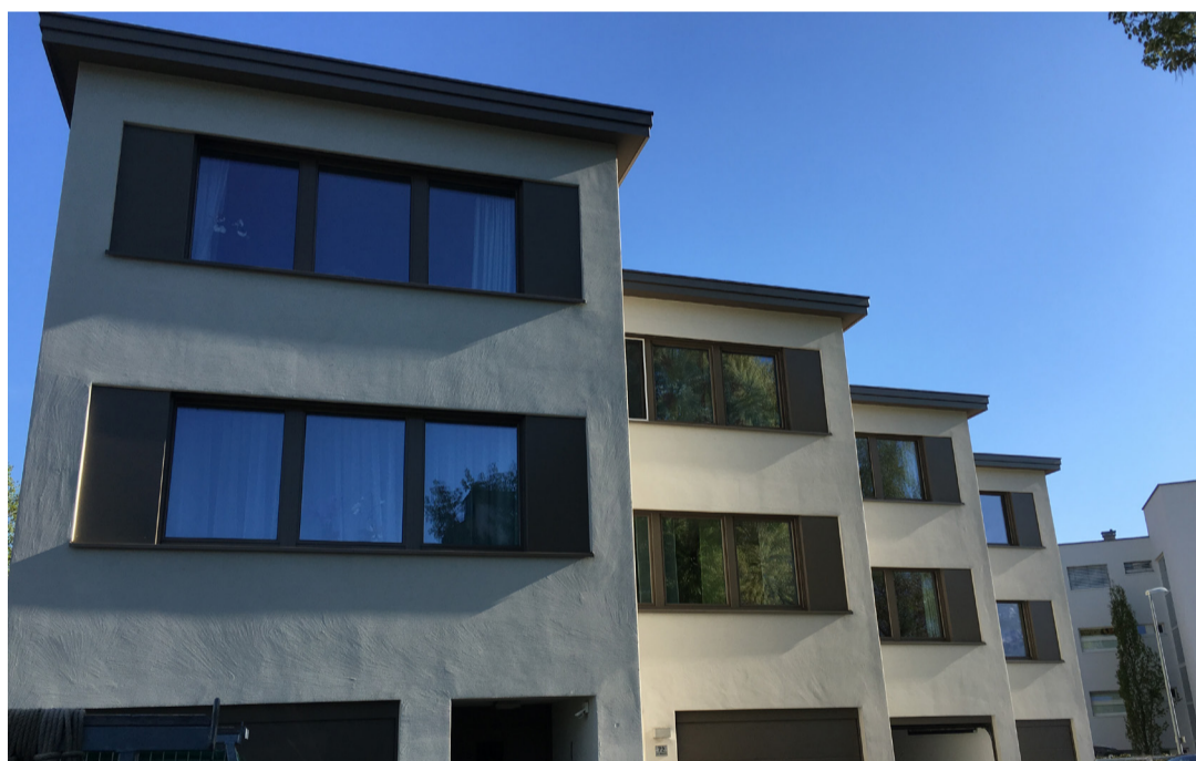
Les quatre maisons individuelles contiguës en décroché. La consommation énergétique des deux maisons diffère de vingt pour cent en raison des différents matériaux constituant la chape dans laquelle le chauffage par le sol est intégré.
