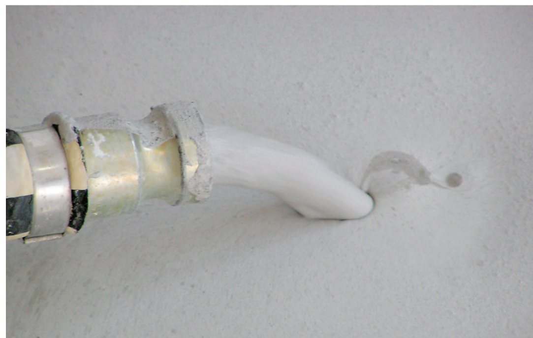
La chape fluide à base de sulfate de calcium a juste besoin d'être injectée et répartie avec la barre de répartition, après quoi elle se répand automatiquement et se compacte. Ce qui signifie qu'il est possible d'obtenir des rendements journaliers allant jusqu'à 1'500 mètres carrés sans effort physique important.
