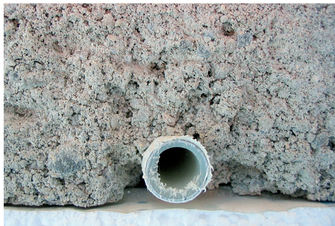
La structure fait toute la différence en matière de répartition de la chaleur : en haut la chape fluide à base de sulfate de calcium, qui entoure les conduites de chauffage, et en bas une chape poreuse en ciment.
