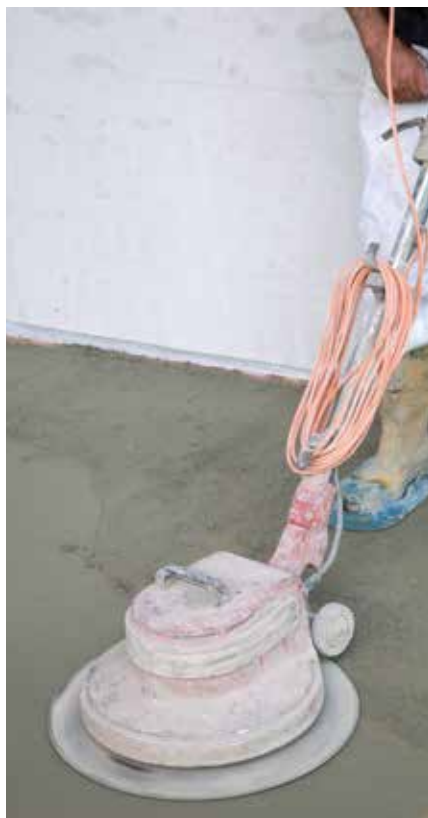
Zaglađivanje estriha strojem
