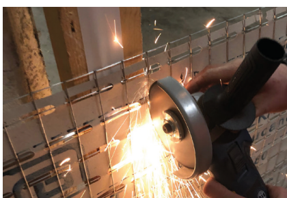
Montage Stucanet® 80 bei Leichtbauwänden
