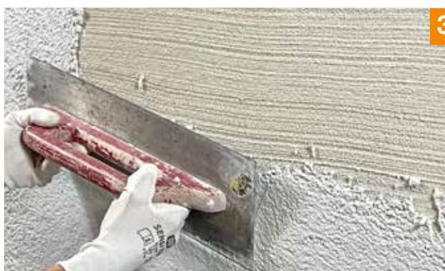
3. Sur la couche d'armature, appliquer le crépi lavé Fixit 794 plus avec un tout petit peu plus que l'épaisseur de grain.
