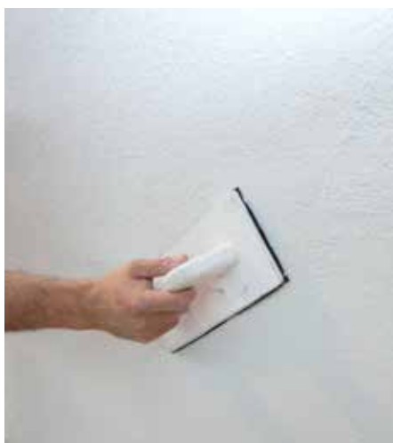
Strutturare con RÖFIX Renopor® Collante e rasante specifico
