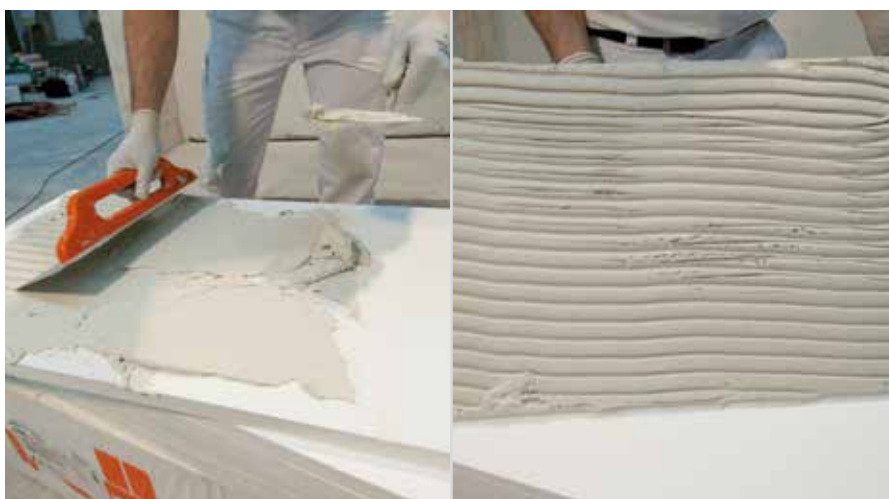
Incollaggio su tutta la superficie con RÖFIX Renopor® Collante e rasante specifico
