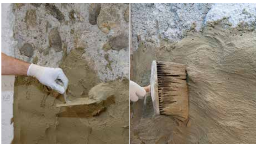
Applicare in modo irregolare RÖFIX 635
