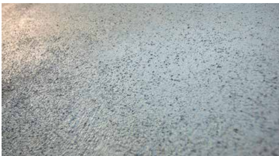
RÖFIX 397, 2. strato strutturato
