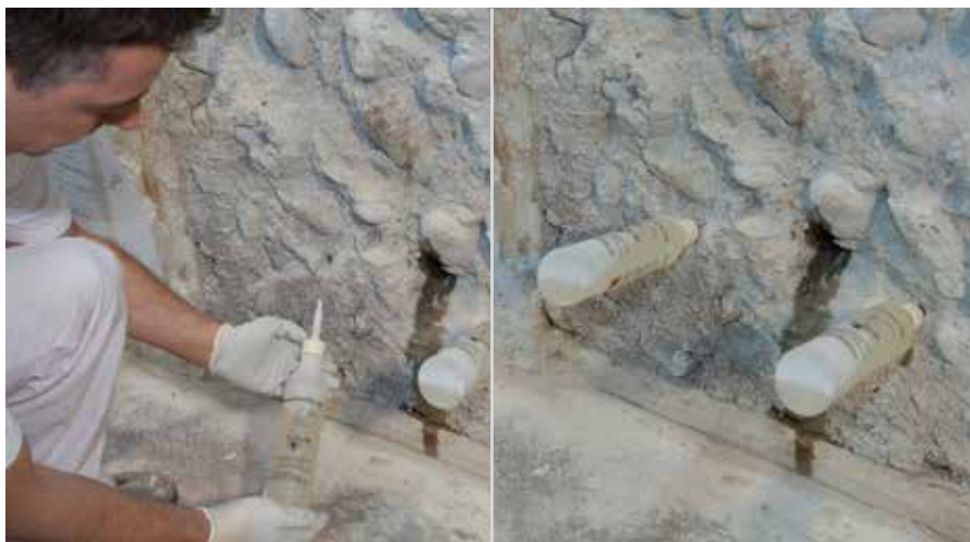
Iniettare RÖFIX Cavastop 10–15 cm superiore del pavimento
