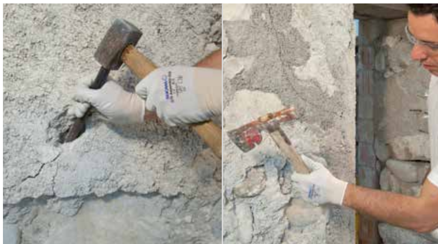
Rimozione dell'intonaco vecchio
