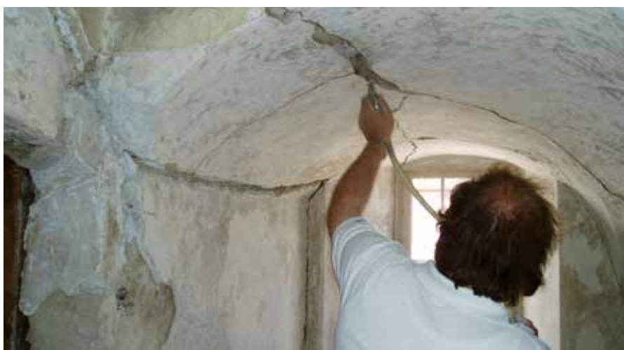
Riempimento di fessure nell'intonaco
