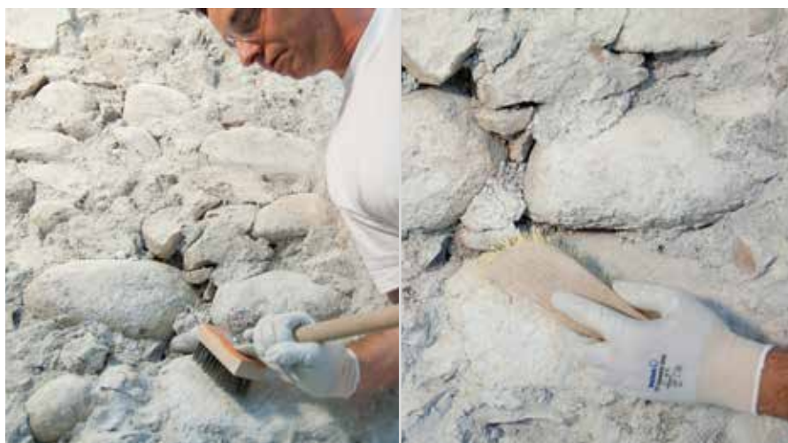
Scoprimento e pulizia della muratura.
