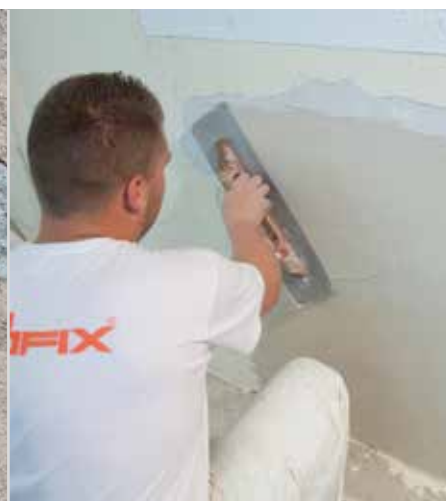
Compensare irregolarità di intonaco
