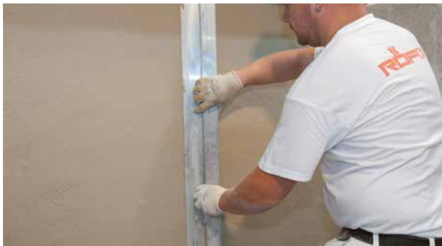
Rasatura di RÖFIX CalceClima® Thermo
