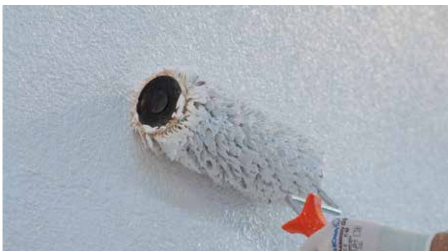
Rivestimento con pittura
