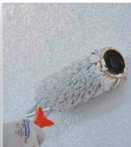
Rivestimento con pitture permeabili al vapore
