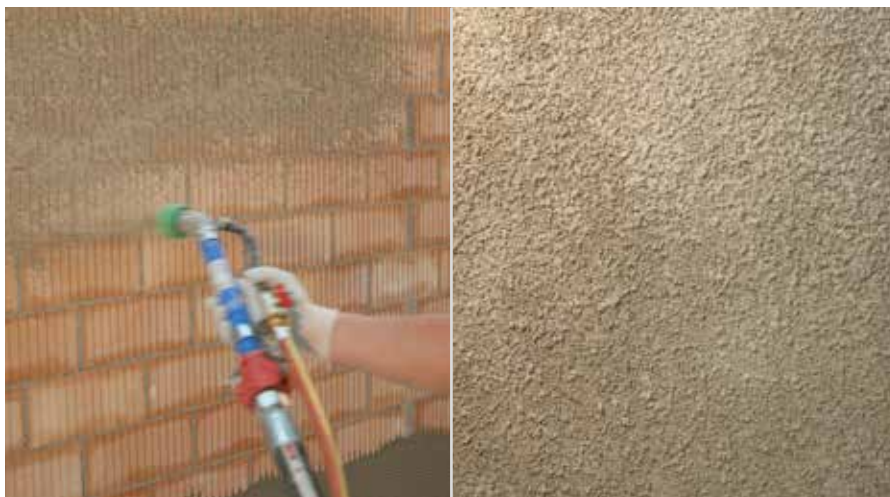
Pretrattamento del supporto
