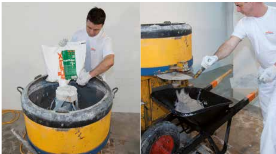
Miscelazione del sistema componibile
