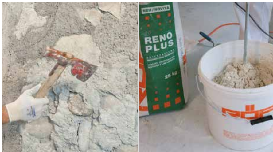
Rimozione dell'intonaco vecchio
