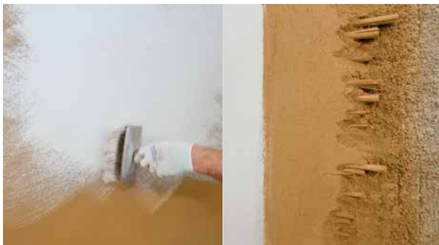
Rivestimento con RÖFIX PE 819 SESCO Pittura ecologica alla calce
