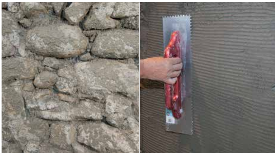
RÖFIX 671 Malta da rinforzo per risanamento su 60% della superficie | Applicare e rigare RÖFIX 648
