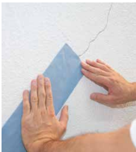
Applicare RÖFIX Striscia adesiva per restauro delle fessure
