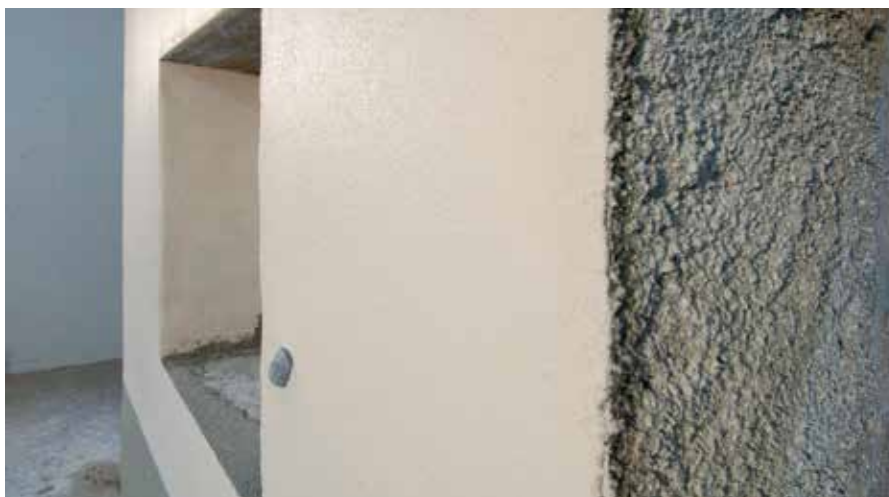
Applicazione del rivestimento (RÖFIX 380)
