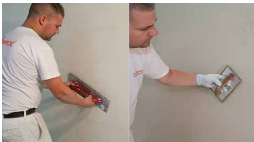
Applicazione del rivestimento minerale RÖFIX CalceClima® Fino
