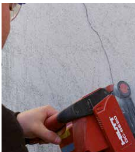
Fresare la fessura
