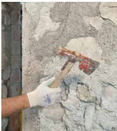
Rimuovere l'intonaco vecchio
