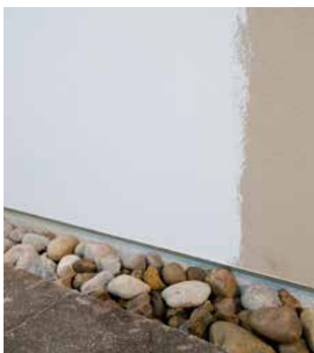
Esecuzione zoccolatura con profilo
