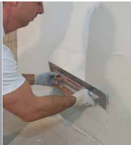
Rasatura con RÖFIX Renopor® Collante e rasante specifico
