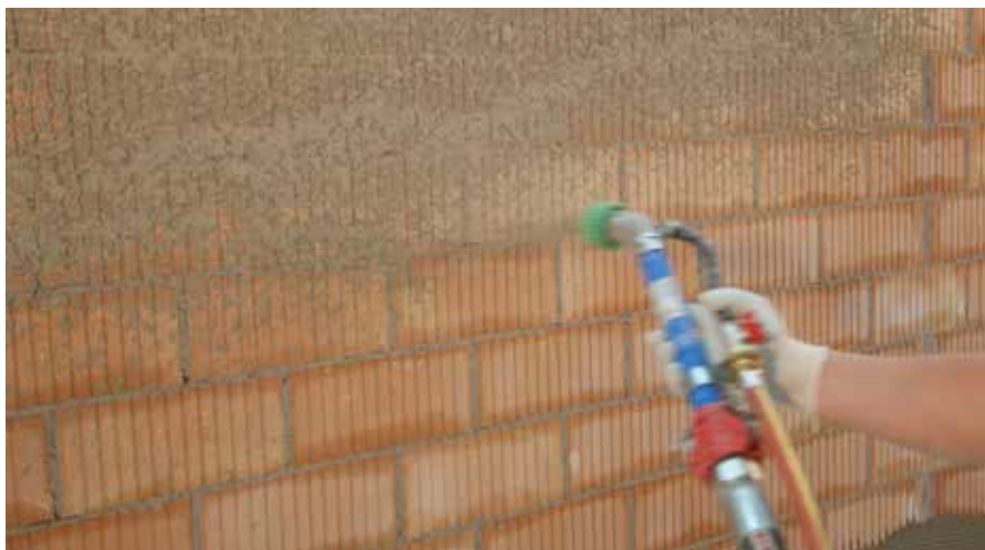
Pretrattamento del supporto
