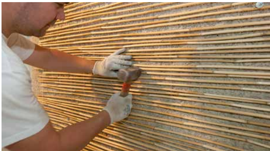
Pretrattamento del supporto
