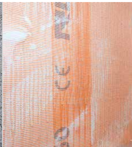
RÖFIX Renoplus® armatura con rete
