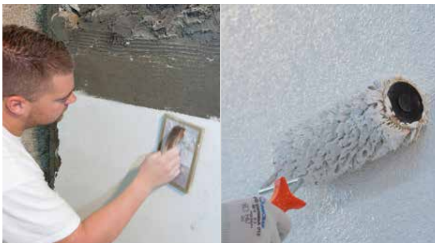
Strutturare e rifinire RÖFIX 340/341
