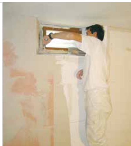
Montaggio con RÖFIX Renopor® Accessorio cuneiforme per soffitti
