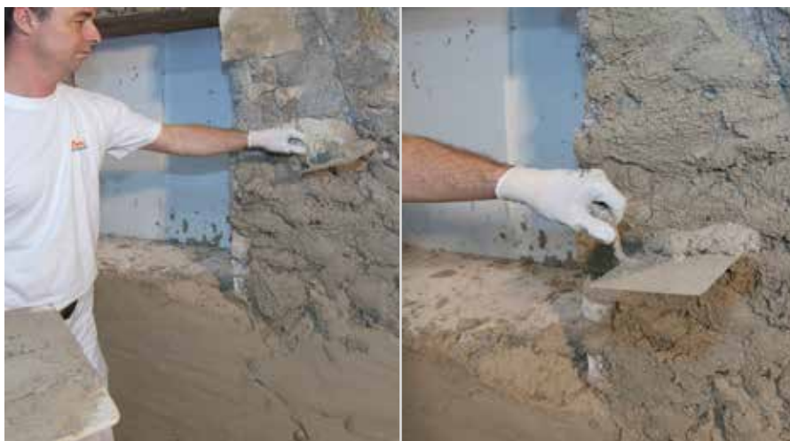
Applicazione dell'intonaco a base calce
