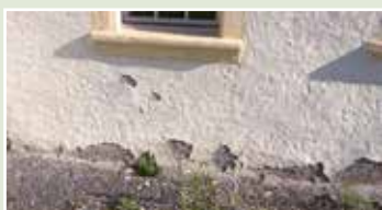
Impermeabilizzazione di murature
