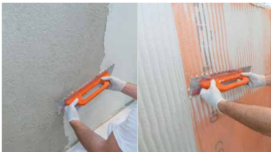
Armatura dello strato di intonaco termoisolante
