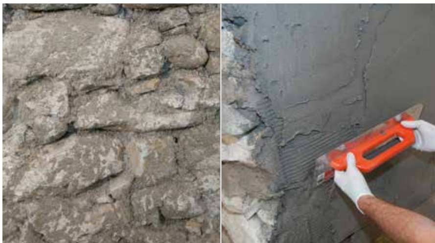
RÖFIX 671 Malta da rinforzo per risanamento su 60% della superficie | Applicare min. 20 mm di RÖFIX 640
