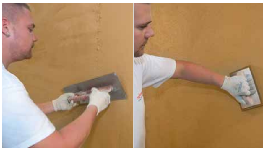
Applicazione dello strato di finitura
