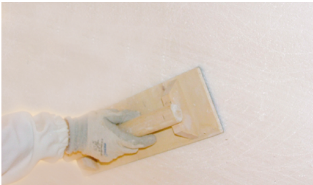
Oberfläche der EPS-Fassade schleifen
