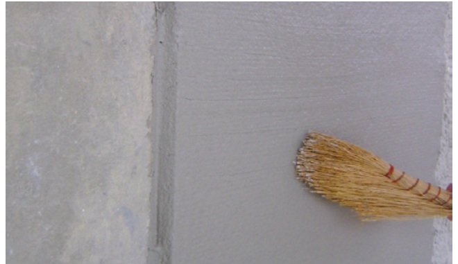
Aufrauen des Grundputzes mit dem Besen
