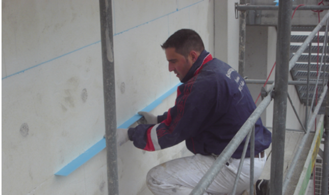
Offene Plattenstösse mit XPS-Keilen verschliessen
