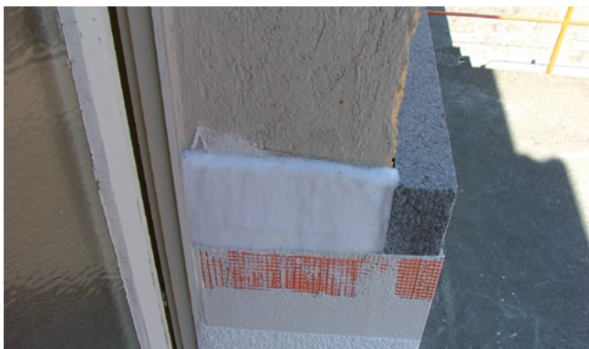
Leibung mit Aerogel und Putzaufbau
