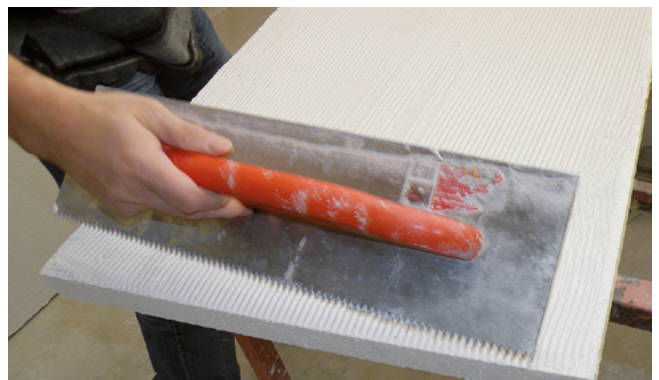
Auftragung des Klebers mittels Zahntraufel
