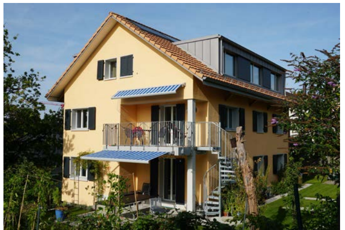
Ristrutturazione di una casa unifamiliare, St. Gallen
