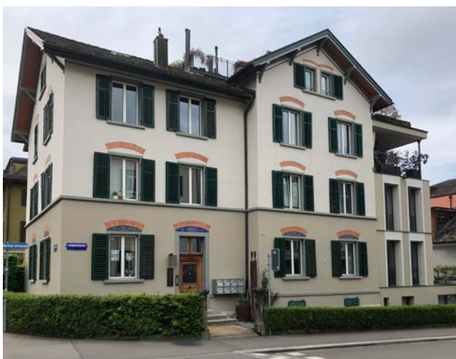
Facciata di 10 anni con aerogel senza manutenzione
