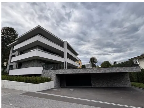
Sur le garage, les briques ont été collées directement sur le béton.
