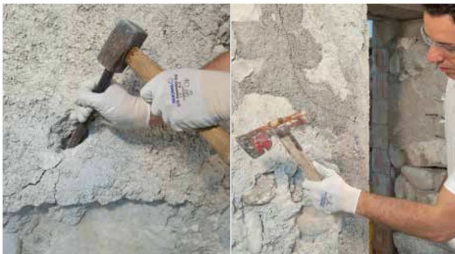
Obijanje stare žbuke
