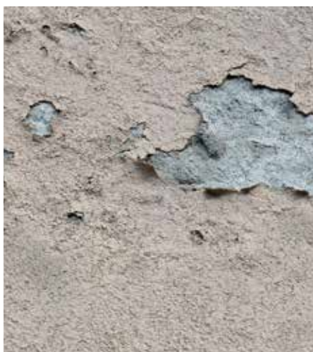
Odvajanje završne žbuke
