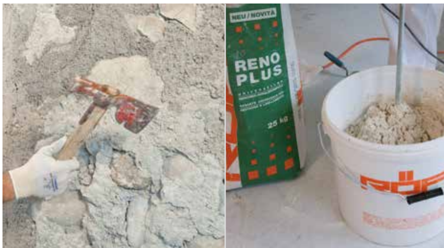
Obijanje stare žbuke
