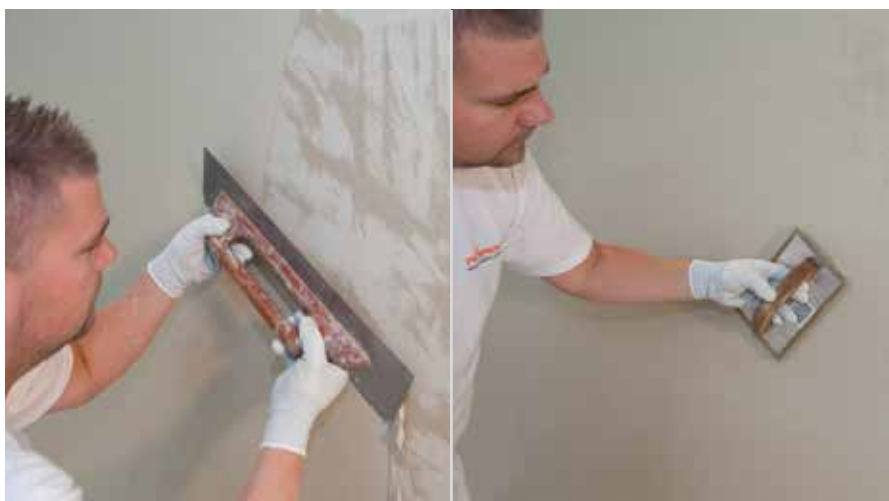
Nanošenje RÖFIX CalceClima® Fino
