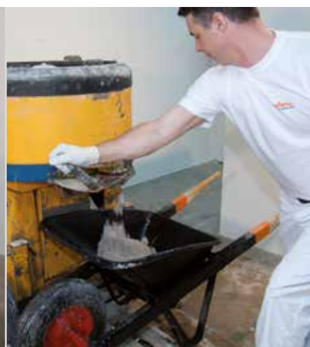
Izlijevanje gotovog morta za žbukanje
