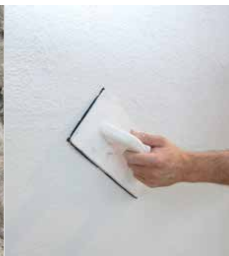
Nanošenje i strukturiranje RÖFIX 650 bijela
