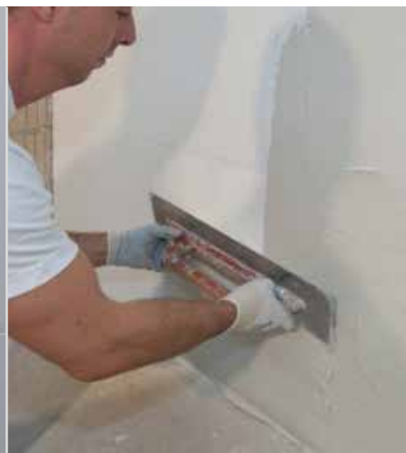
Armiranje pomoću RÖFIX Renopor® Specijalnog ljepila
