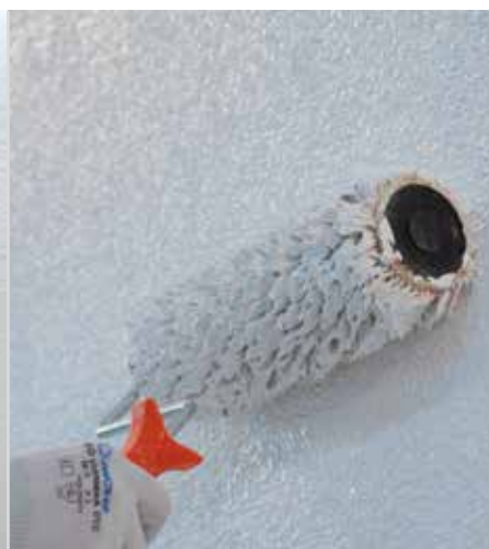
Premazivanje s paropropusnim bojama
