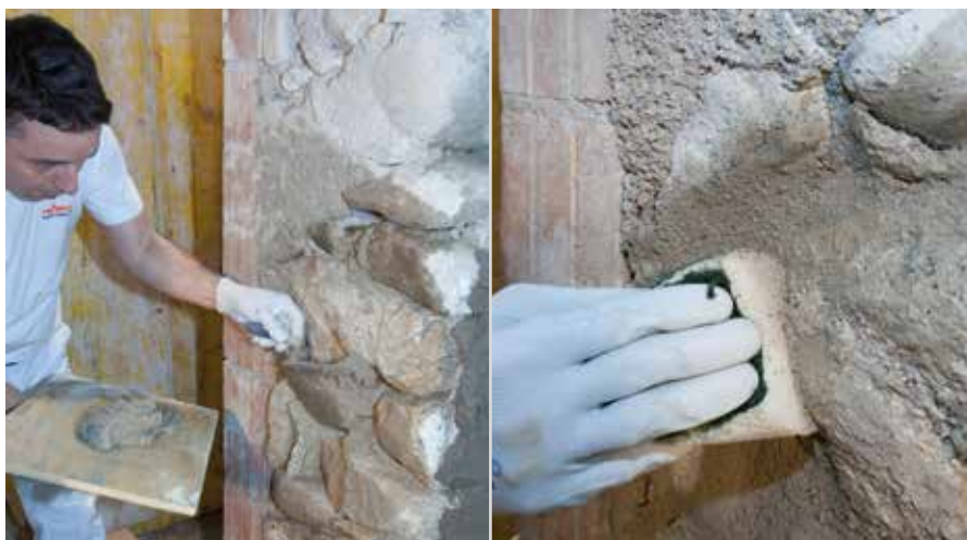
Fugiranje zida od prirodnog kamena
