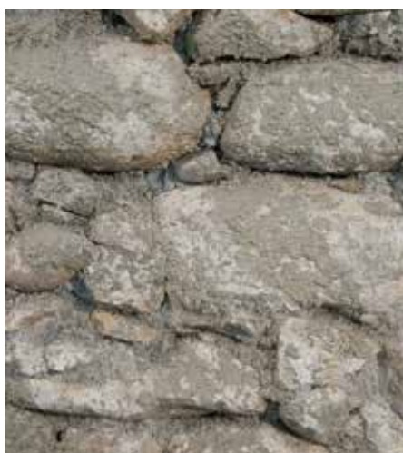
RÖFIX 671 Špric za saniranje uz 60 %-tno prekrivanje površine
