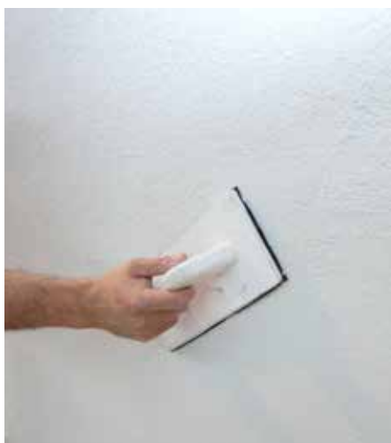
Strukturiranje pomoću RÖFIX Renopor® Specijalnog ljepila
