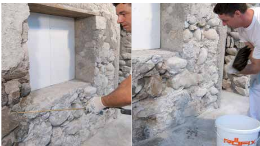
Navlaživanje podloge prskalicom za špricanje stabala Navlaživanje podloge soboslikarskom četkom
