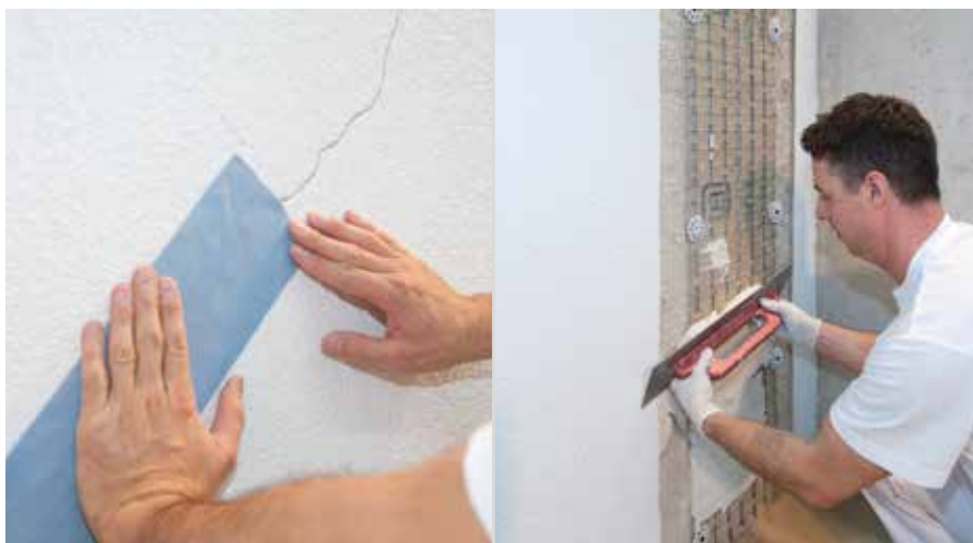
Postavljanje RÖFIX Trake za saniranje pukotina
