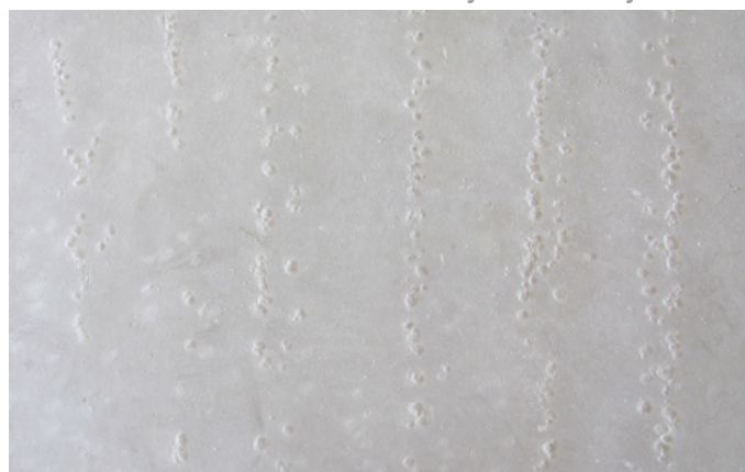
Abb. 25: Beispiel für die Bläschenbildung an der Oberfläche von Fließestrichen
