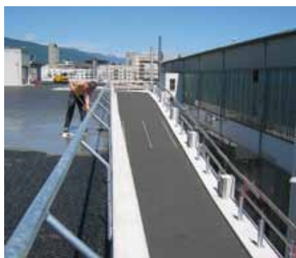
Parkirne garaže uključujući prilazne putove
