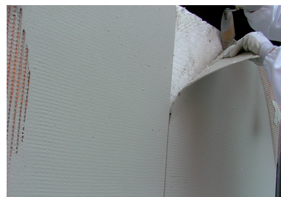
Rimozione dell'intonaco dai pannelli in polistirolo EPS
