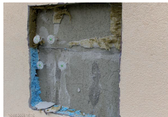
Sondaggio di grandi superfici
