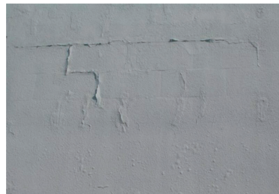
Rigonfiamenti e formazioni di bolle su ampie superfici
