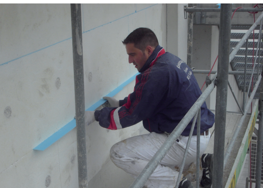
Sigillare i giunti aperti dei pannelli con zeppe in XPS
