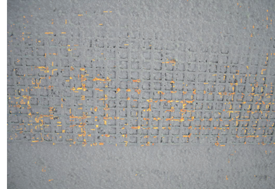
Inserimento della rete sintetica
