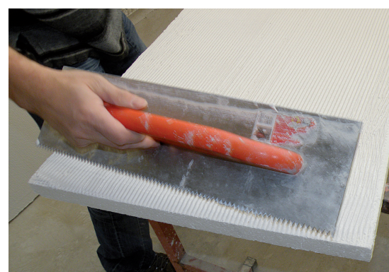
Applicazione del collante con talocchia dentata.
