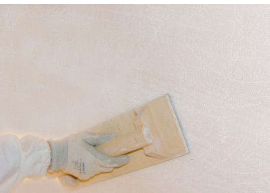
Levigare la superficie di facciate in EPS
