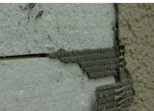
Malta nei giunti dei pannelli
