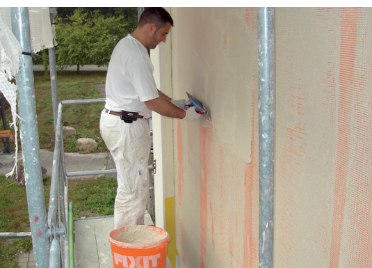
Intonaco di fondo con incorporamento di rete sintetica
