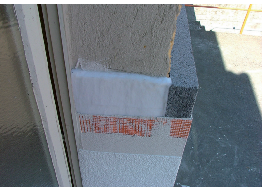
Mazzetta con pannello Aerogel e intonaco di finitura
