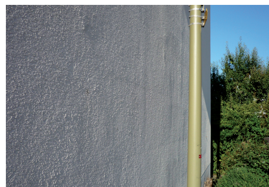
Evidenziazione dei giunti dei pannelli
