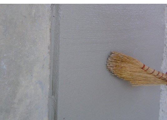
Irruvidire l'intonaco di fondo
