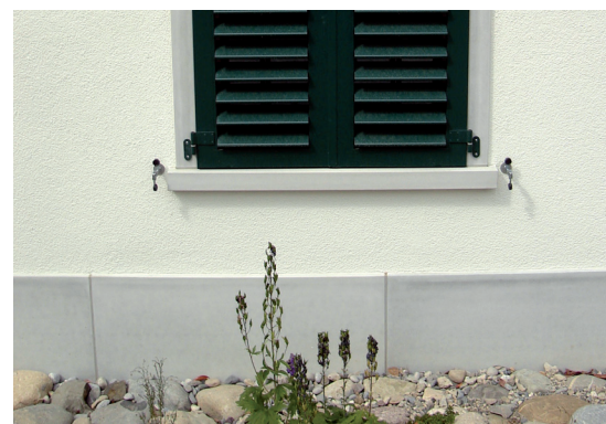
Zoccolatura con lastre in cemento fibrato (GFB)
