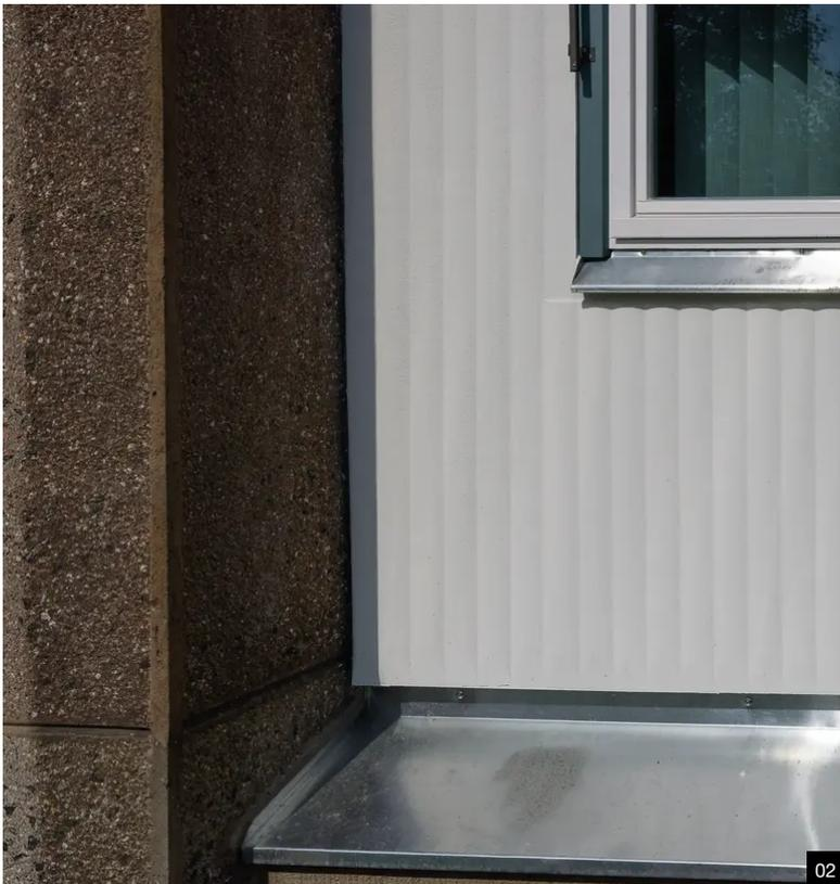
01-04| Detailansichten der neu sanierten Fassade des Andreas-Schubert-Baus in Dresden. Deutlich erkennbar ist der Erhalt der ursprünglichen Oberflächengestaltung mit dem charakteristischen senkrechten Kammzug. Das markante Sichtbetonskelett der Fassade wurde bewusst unverändert belassen, um den architektonischen Ausdruck und die denkmalgeschützte Ästhetik des Gebäudes zu wahren.
