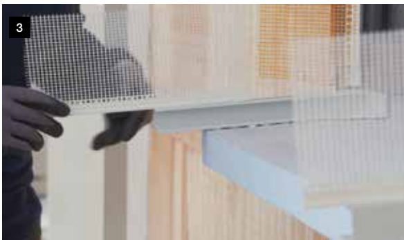
3 SOL-PAD Anputzleiste satt und dicht mit MS-Polymer an das Basisprofil und auf die Abdichtung kleben (SOL-PAD Anputzprofil erst nach Trocknung Armierungsmörtel kürzen)
