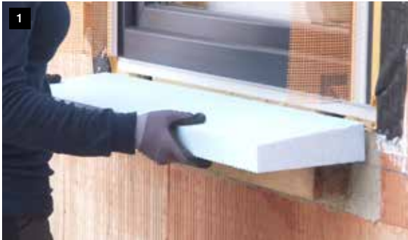
1 SOL-PAD Dämmkeil an Auflagewinkel/-balken mit MS-Polymer kleben
