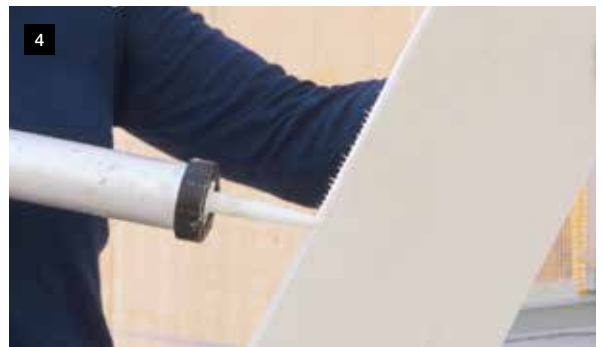
4 RENOTECT Platte auf Dicke FOME® Dämmschutz zurecht schneiden und seitlich mit MS Polymer bekleben
