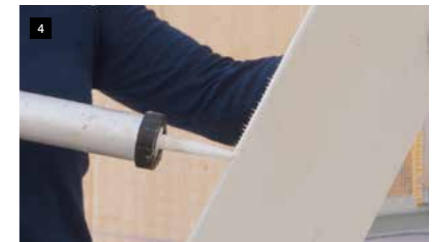
4 RENTECT Platte auf Dicke FOME® Dämmschutz zurecht schneiden und seitlich mit MS Polymer bekleben
