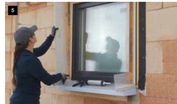
5 Leibungsplatten mit der Klebeseite auf das Anputzprofil drücken
