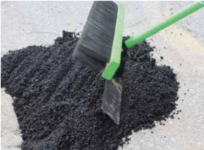
Verteilen des Materials mit Hilfe eines Rechens oder eines Spezialwerkzeugs in homogener und ebener Form, in einer Mindestdicke von 2 cm.
