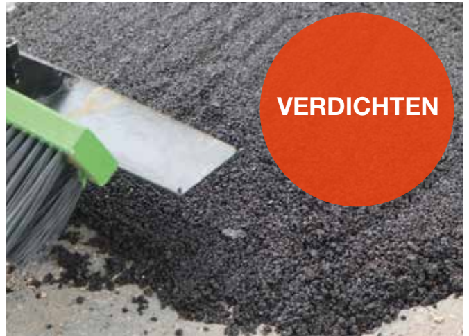
Produkt auf dem Untergrund verdichten und klopfen, so dass es anhaftend, stabil und kompakt wird.
