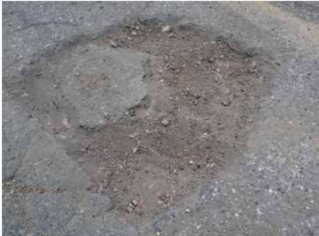
Der Untergrund muss grob sauber sein, außerdem frei von losen oder sich lösenden Teilen.
