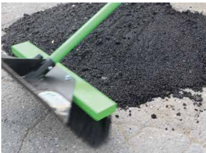
Reinigung und Nachbearbeitung mit einem Besen.
