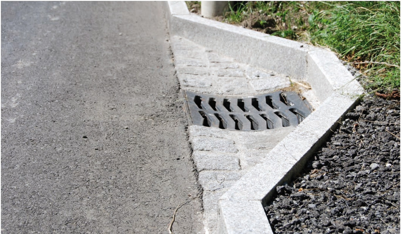
Schacht im Toggenburg Fixit 585 Vergussmörtel, Fixit 587 Schachtversetzmörtel
