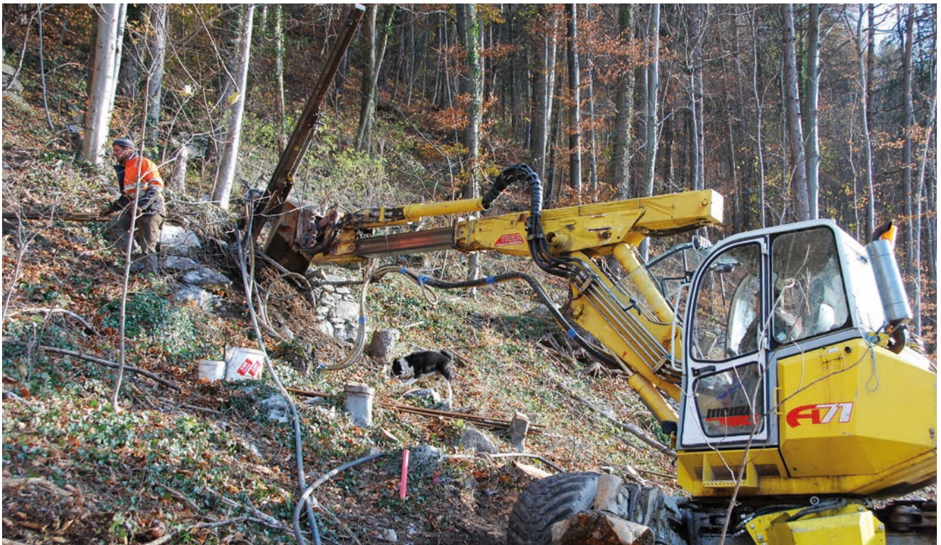
SSS Pasati, Sargans Fixit 532 Ankermörtel für Lawinverbauungen
