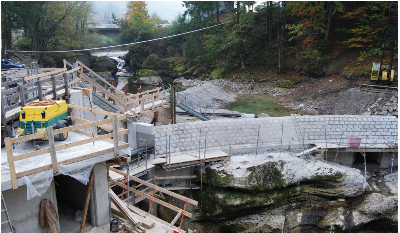
KW Krummenau Fixit 508 und Fixit 508 Pump Trockenbeton, Fixit 560 Natursteinmörtel
