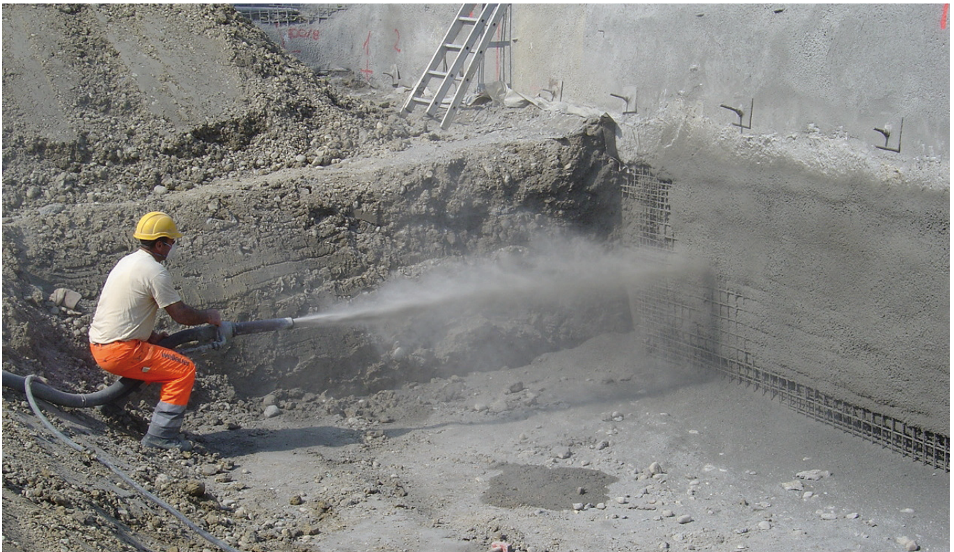
Aadorf Fixit 527 A Trockenspritzbeton
