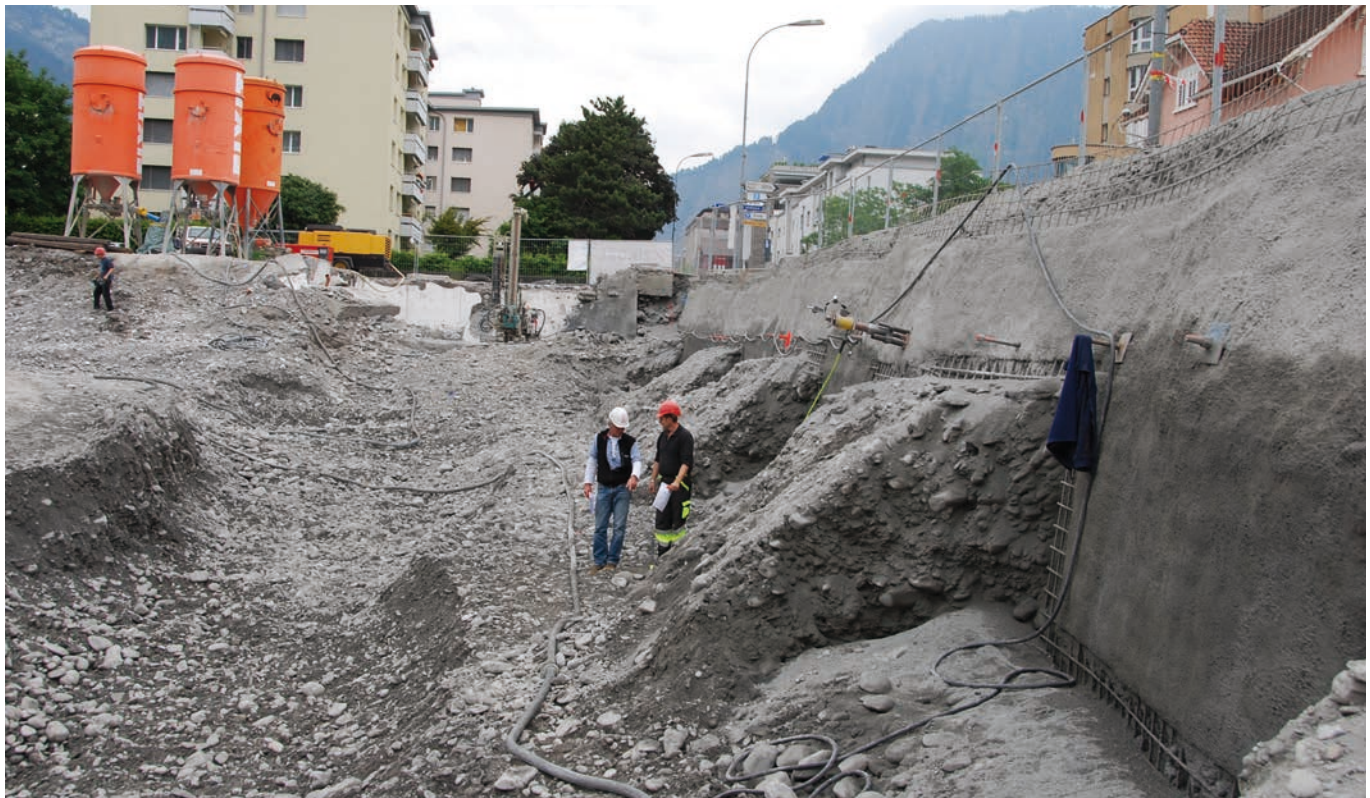
ÖKK, Landquart Fixit 526 A Baugrubengunit C25/30 und Fixit 530 Injektionsmörtel
