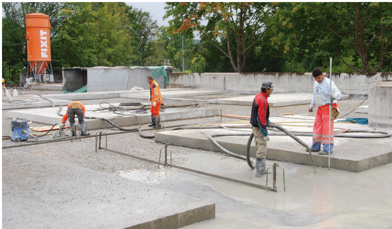
Kantonsspital, Frauenfeld Fixit 508 P1 Pump Trockenbeton C30/37 0 – 8 mm
