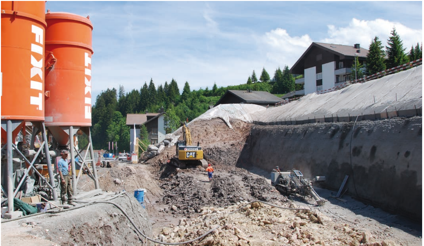
Flumserberg Fixit 527 A Trockenspritzbeton, Fixit 530 R Injektionsmörtel schnell abbindend
