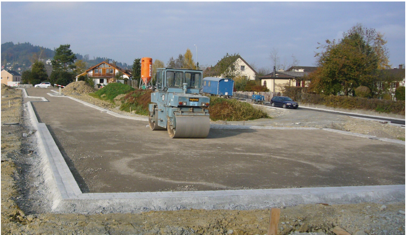
Erschliessung Schiin, Uzwil Fixit 583 Bundsteinmörtel und Fixit 516 FT Trockenbeton C30/37, 0 – 16 mm
