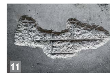
11 Ремонт і відновлення бетону
