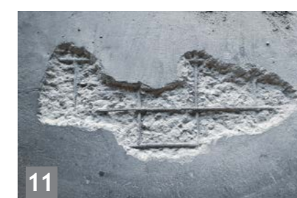
11 Ремонт і відновлення бетону
