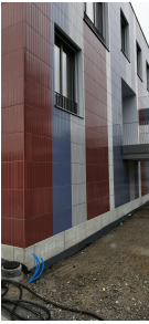
Sockelabschluss mit GFB- Elementen ausgeführt
