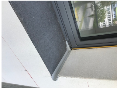
Fensterbank-Auflager mit Sol-Pad Abdichtung mit Fixit 374
