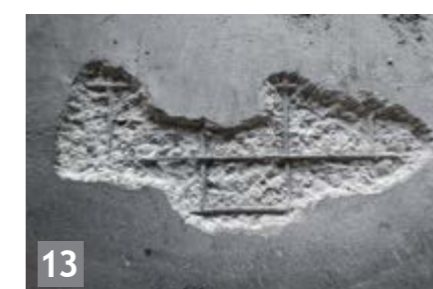
13 Ремонт і відновлення бетону
