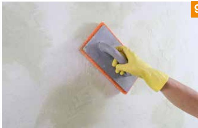
**9.** Nach der Trocknung des zweiten Anstrichs erfolgt die Fleckentechnik mit der Schwammscheibe. Die Fassadenfarbe (max. 10% verdünnt) wird mit einem Pinsel aufgebracht und mit der feuchten Schwammscheibe verrieben. Der Vorgang wird solange wiederholt, bis der Grundton nicht mehr ersichtlich ist.
