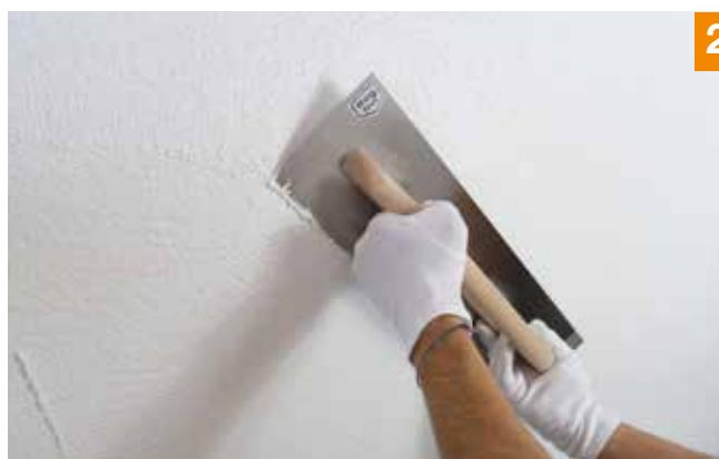
2. Nach der Trocknung wird die Grundbeschichtung mit dem Fixit 740 Si, 0.7 mm, überzogen und ohne Absätze abgeglättet. Gegebenenfalls sind Traufelschläge von der Grundbeschichtung vorgängig zu schleifen.
