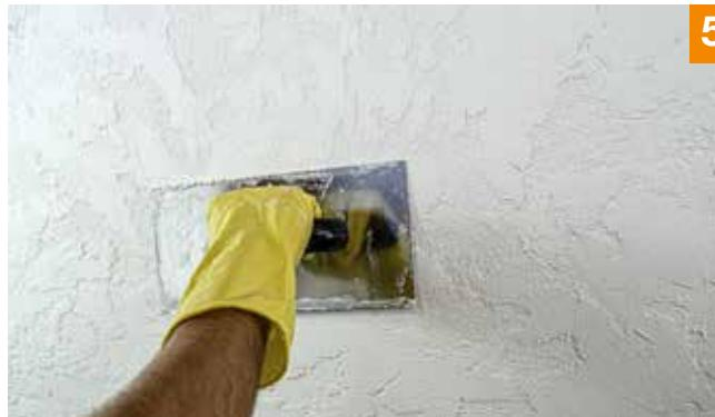
**5.** Die Rindenstruktur leicht anziehen lassen und mit der kleinen Stahltraufel vorsichtig abglätten.
