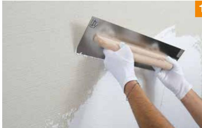
1. Auf die Armierungsschicht wird die Grundbeschichtung mit dem Fixit 740 Si, 1.5 mm V, auf Kornstärke aufgezogen und ohne Absätze abgeglättet.
