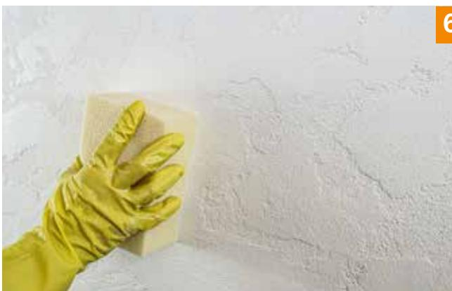
**6.** Nach dem Anziehen des Putzes werden die Übergänge mit dem Schwamm leicht abgefilzt.
