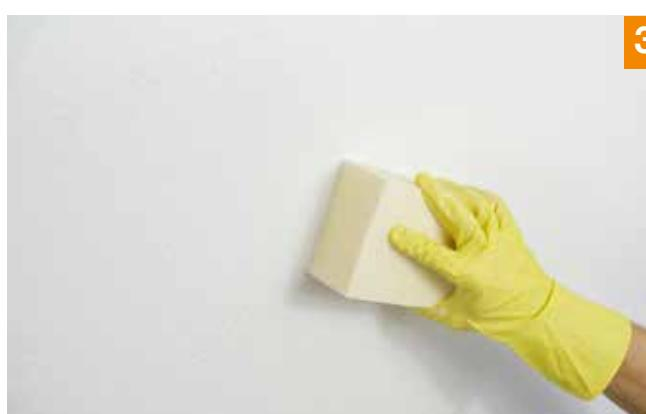
3. Den Fixit 740 Si, 0.7 mm, leicht anziehen lassen und mit dem Schwamm abfilzen.
