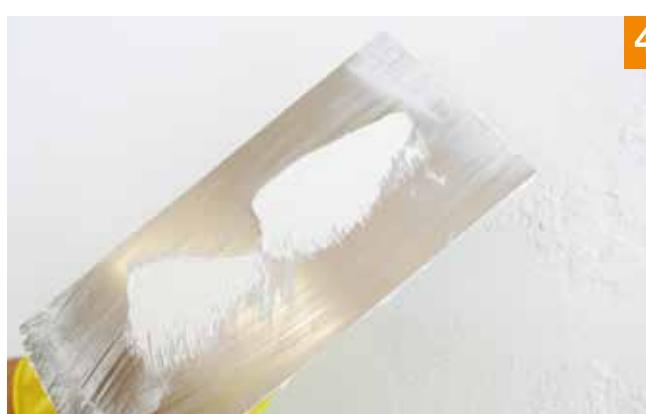
4. Der Untergrund muss vollständig trocken sein. Auf der Edelstahltraufel werden kleine Patschen vom Fixit 740 Si, 0.7 mm, aufgebracht, an die Wand gedrückt und in alle Richtungen verzogen. Die Rindenstruktur wird massgeblich durch die Grösse und Abstand der Patschen beeinflusst.
