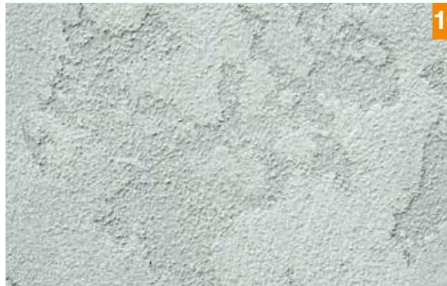
**10.** Die Intensität der Rindenstruktur variiert mit dem Farbunterschied zwischen dem Grundton und dem Farbton der Fleckentechnik.
