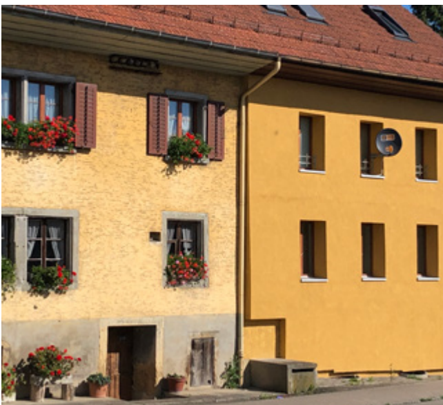
Die rechte Fassade wurde zwar neu gedämmt, jedoch ging dadurch die Geschichte des Hauses verloren.
