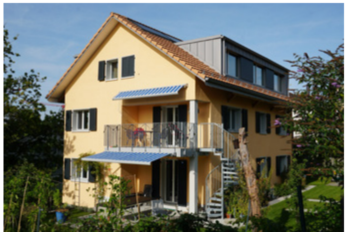
EFH-Sanierung, St. Gallen
