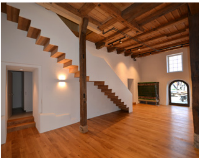
Innendämmung mit Aerogel Hochleistungs-dämmputz (1. Preis Aerogel Award der Empa 2021)
