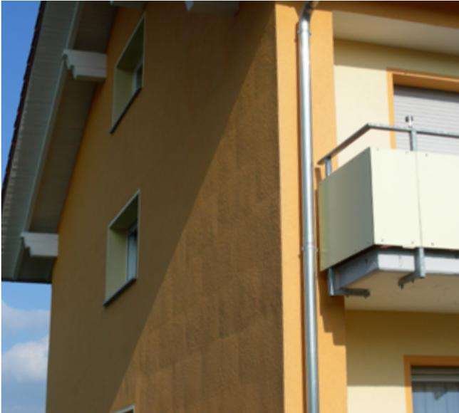
Streiflicht auf der Fassade bei Dämmplatten; die Platten sind sichtbar, müssen aber gemäss SIA 243 «Verputzte Aussenwärmedämmung» akzeptiert werden.
