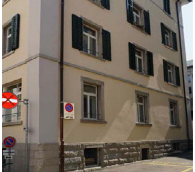
Streiflicht auf der Fassade mit Aerogel Hochleistungsdämmputz; die Dämmung ist auf dieser Fassade nicht sichtbar.
