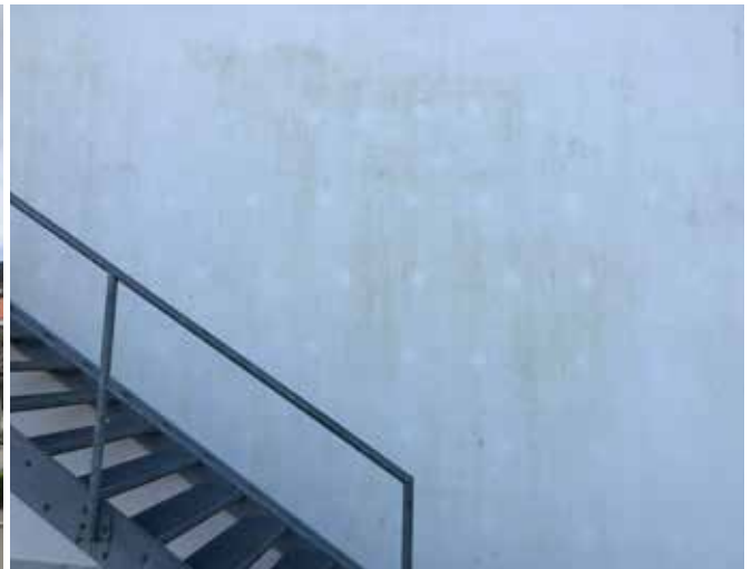
10-jährige Fassade mit verputzter AWD
