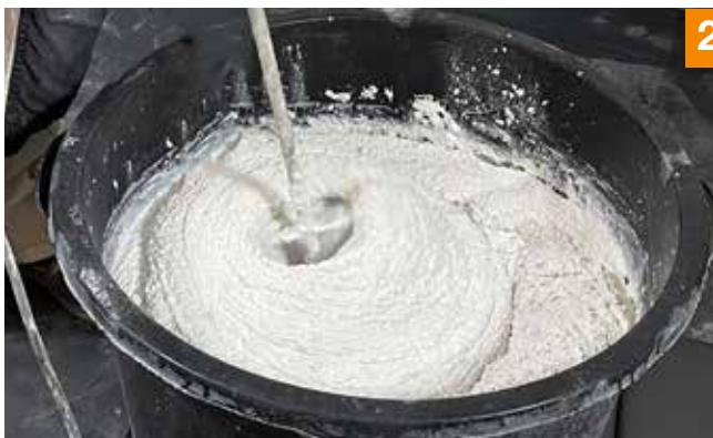
2. Fixit 794 plus Waschputz in einer grossen Mörtelwanne mit dem Rührwerk anmischen, ca. zehn Minuten ruhen lassen und dann nochmals kurz aufmischen.
