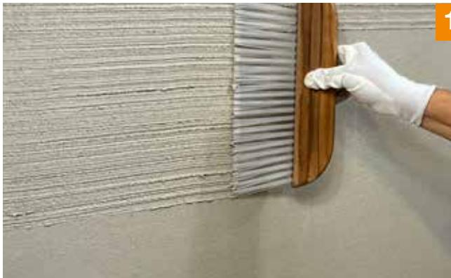
1. Die Armierungsschicht wird für den nachfolgenden Putzauftrag horizontal mit der Aufräubürste aufgeraut.
