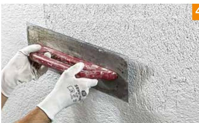
4. Die aufgezogene Fläche muss nach dem Putzauftrag absolut plan sein. Je nach gewünschter Textur und Modellierung kann die Schichtstärke bis maximal auf das 1,5-fache des Materialkorns erhöht werden.
