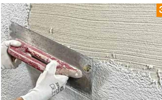
3. Auf die Armierungsschicht wird der Fixit 794 plus Waschputz im ersten Arbeitsgang knapp über Kornstärke aufgezogen.
