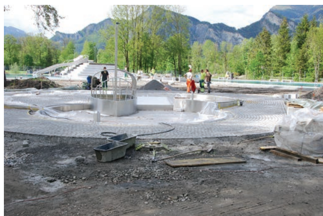
Fixit 585 Malta di sigillatura per pavimentazioni 0 – 3 mm e Fixit 583 Malta d'assemblaggio per selciati 0 – 3 mm e bordure, resistant al gelo e sali disgelanti
