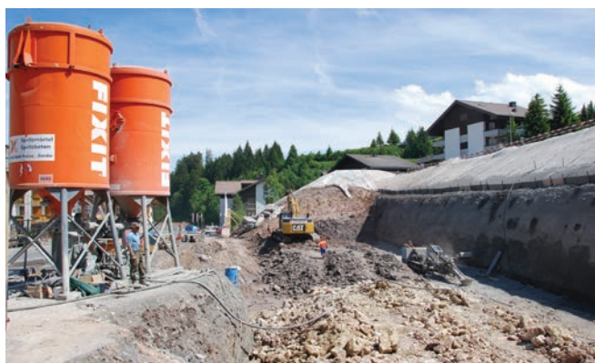
Fixit 527 A Beton a spruzzo per stabilizzare gli scavi Fixit 530 R Malta d'iniezione a presa rapida
