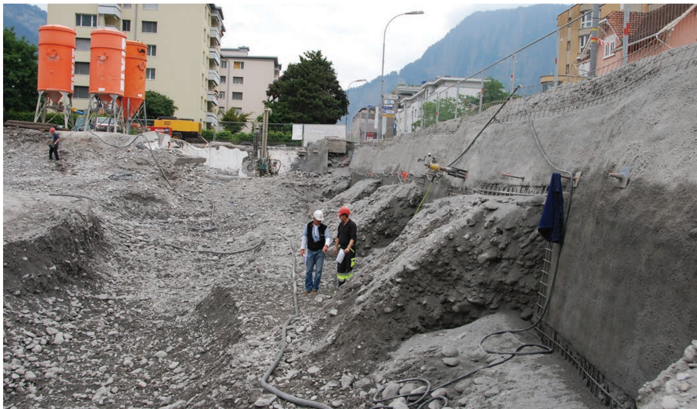
Fixit 526 A Beton secco a spruzzo per il consolidamento di scavi C25/30 et Fixit 530 Malta per iniezioni
