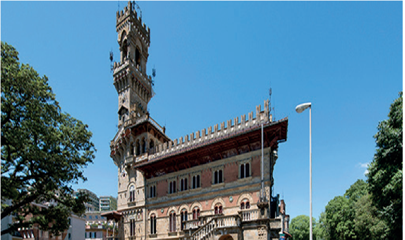
Sistemi di risanamento e restauro
