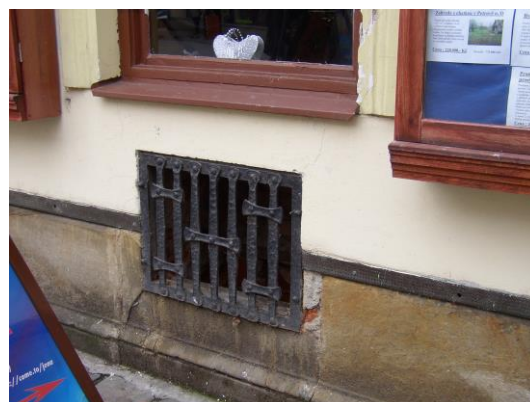
Fotografie 5.17.3 - 5.17.4 : Detail odvětrání kamenného soklu a odvětrávací měděné lišty
