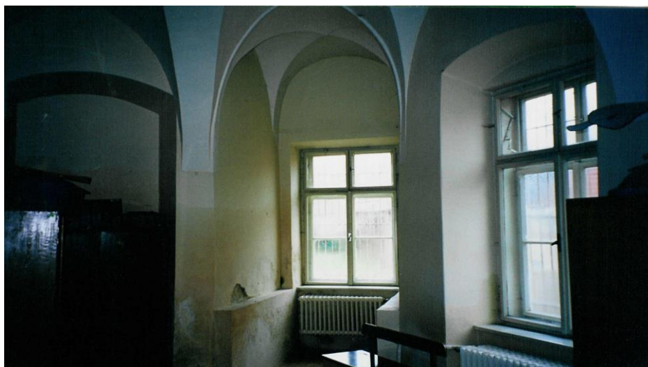
Fotografie 5.8.3 : Původní stav interiéru
