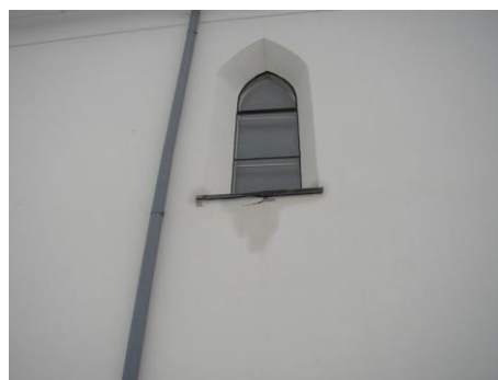
Fotografie 5.4.8 - 5.4.9 : Detail okapu stříšky a detail uložení břidlicové parapetní desky
