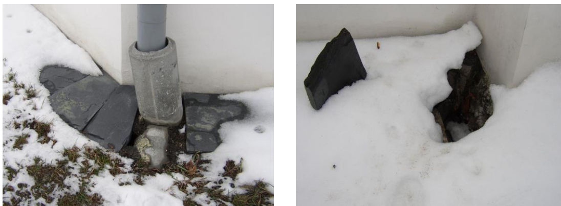
Fotografie 5.4.6 - 5.4.7 : Detaily větrací šachty podél objektu 30.1.2007
