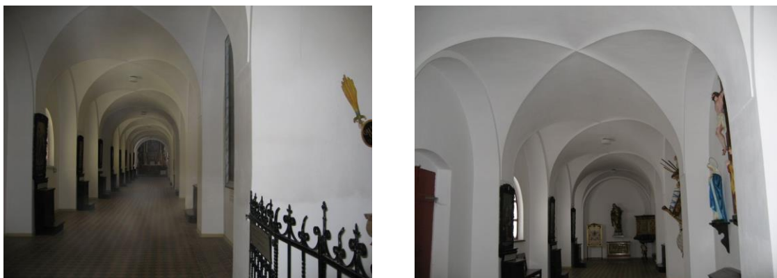
Fotografie 5.5.1 - 5.5.2 : Interiér chodeb kláštera
