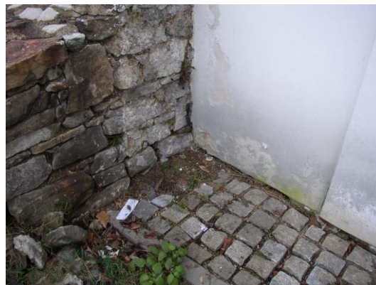
5.16.5 - 5.16.6 : Důsledky odstřikové vody a nevhodného nátěru
