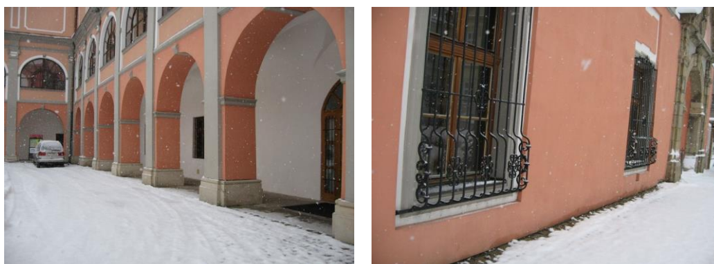
Fotografie 5.1.5 - 5.1.6 : Fasády zámku sanované v roce 2001
