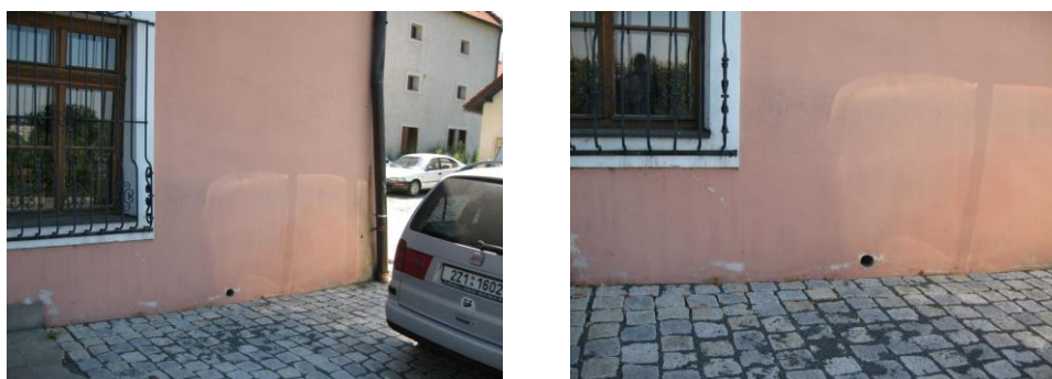
Fotografie 5.1.7 - 5.1.8 : Fasáda zámku nad terasou
