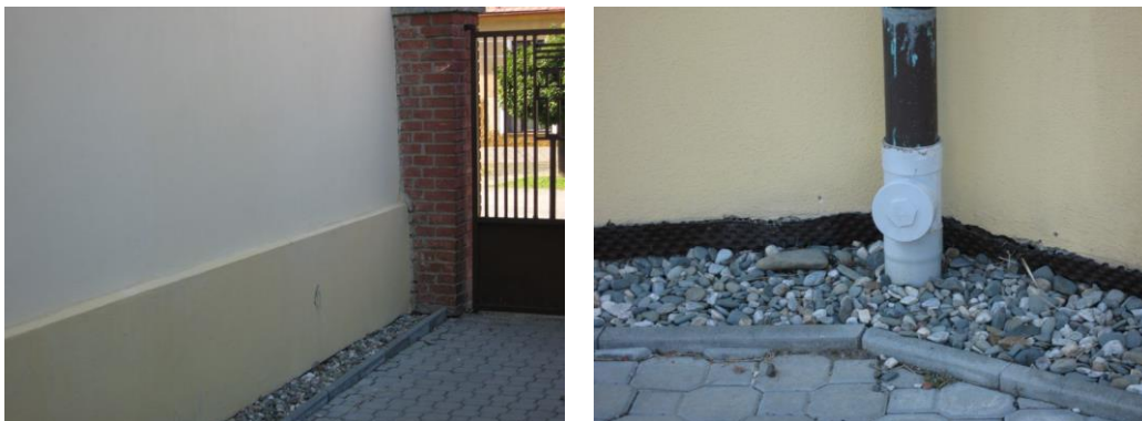
Fotografie 5.3.4 - 5.3.5 : Vnější úprava odvětrání zdiva
