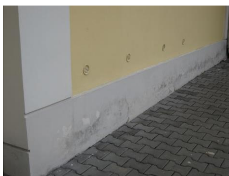
Fotografie 5.14.5 - 5.14.6 : Odvětrávací systém ústí na fasádu kostela
