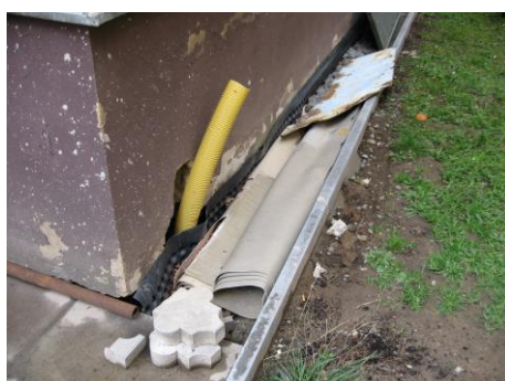
Fotografie 5.7.7 – 5.7.8 : Odvětrávací systém podél objektu
