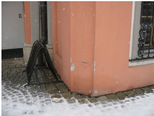
Fotografie 5.1.9 : Detail paty zdi smáčené odstřikovou vodou
