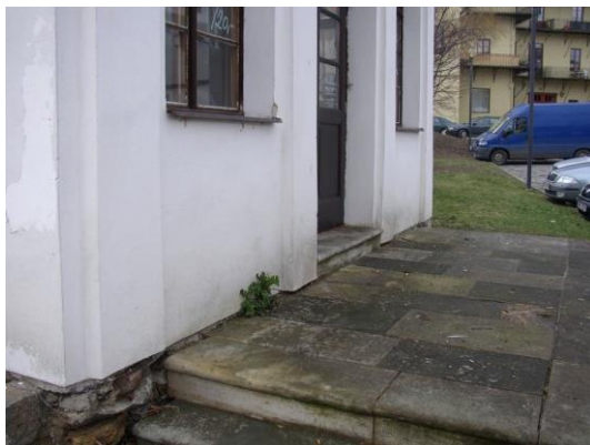
5.16.5 - 5.16.6 : Důsledky odstřikové vody a nevhodného nátěru
