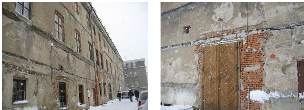
Fotografie 5.1.3 - 5.1.4 : Současný stav jižní fasády zámku v roce 2007
