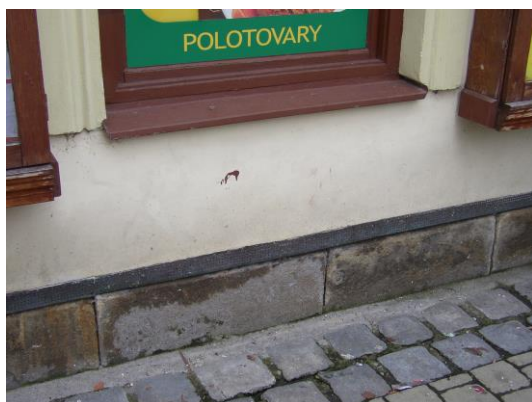
Fotografie 5.17.3 - 5.17.4 : Detail odvětrání kamenného soklu a odvětrávací měděné lišty
