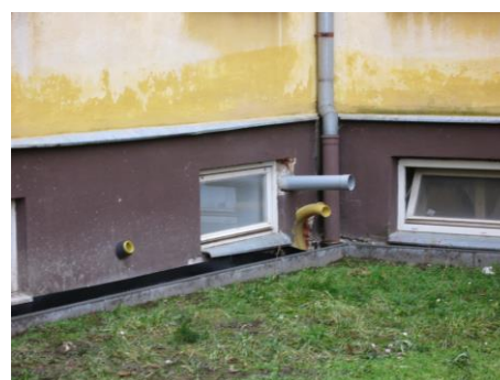
Fotografie 5.7.7 – 5.7.8 : Odvětrávací systém podél objektu
