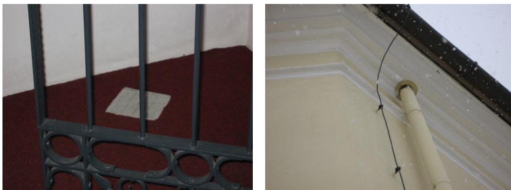
Fotografie 5.3.6 - 5.3.7 : Vnitřní odvětrávací systém kostela
