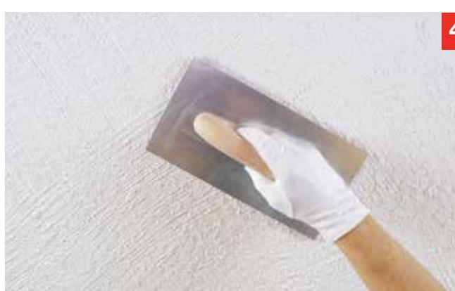
4. Nach der Trocknung des Deckputzes werden die groben Putzüberstände mit einem Schleifbrett (z.B. K16) abgeschliffen.
