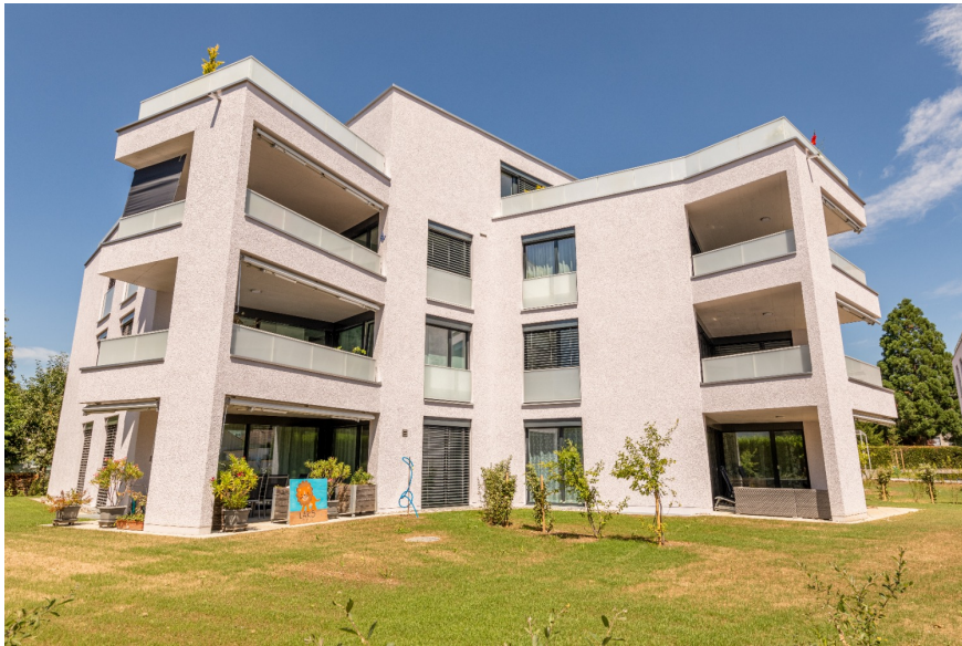
Quelle: Estermann Gipserunternehmen AG
