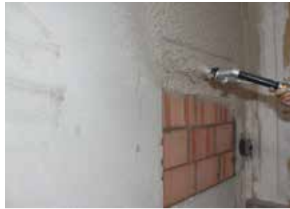
Untergrundaussgleich Fixit 125* / Fixit 632 Rapid
