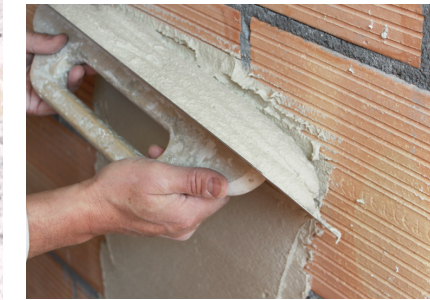
Direkt auf Backstein oder KS Fixit 125 / Fixit 632 Rapid
