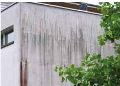
WDVS-Fassaden Sanierung Fixit 461
