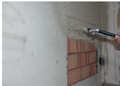
Untergrundaussgleich Fixit 125* / Fixit 632 Rapid
