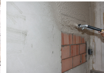
Untergrundaussgleich Fixit 125* / Fixit 632 Rapid
