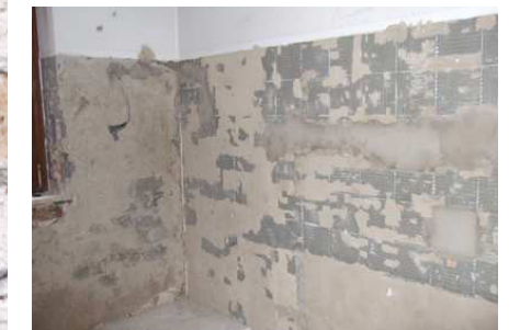
Dispersionsrückstände Fixit 125 / Fixit 632 Rapid
