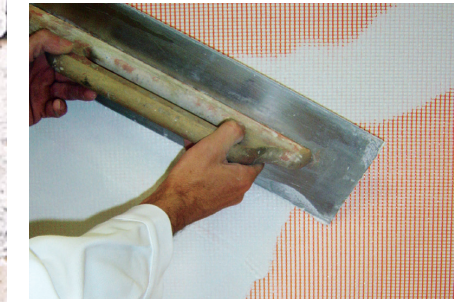
Armierungsgewebe einbetten Fixit 460 / Fixit 461 / Fixit 462
