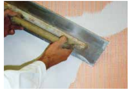
Armierungsgewebe einbetten Fixit 460 / Fixit 461 / Fixit 462
