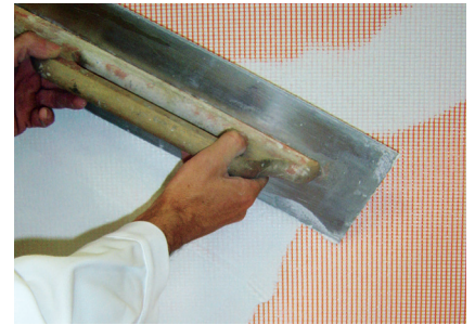
Armierungsgewebe einbetten Fixit 460 / Fixit 461 / Fixit 462
