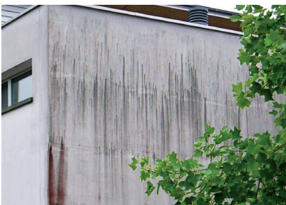
WDVS-Fassaden Sanierung Fixit 461
