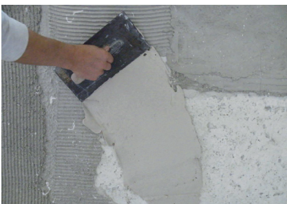
Unterschiedliche alte Untergründe Fixit 125 / Fixit 632 Rapid
