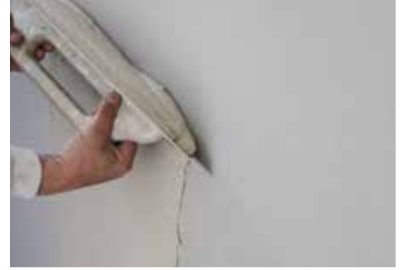
Direkt auf Gipskarton Fixit 125
