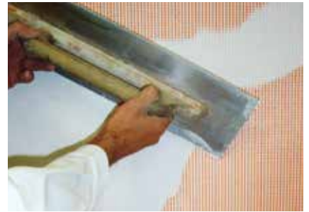
Armierungsgewebe einbetten Fixit 460 / Fixit 461 / Fixit 462
