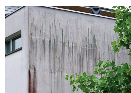
WDVS-Fassaden Sanierung Fixit 461
